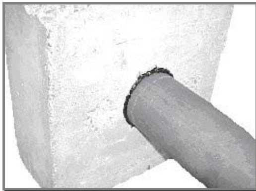
Applicazione di un materiale di tenuta approvato dall'UFPC
