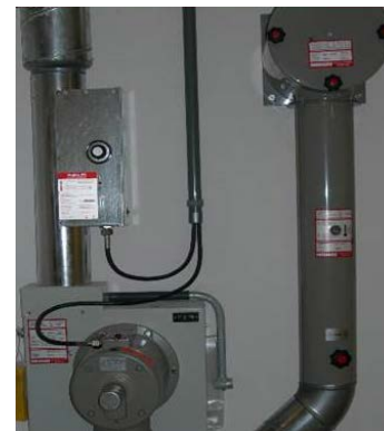
Allacciamento corretto dell'apparecchio VA con sistema riscaldante
