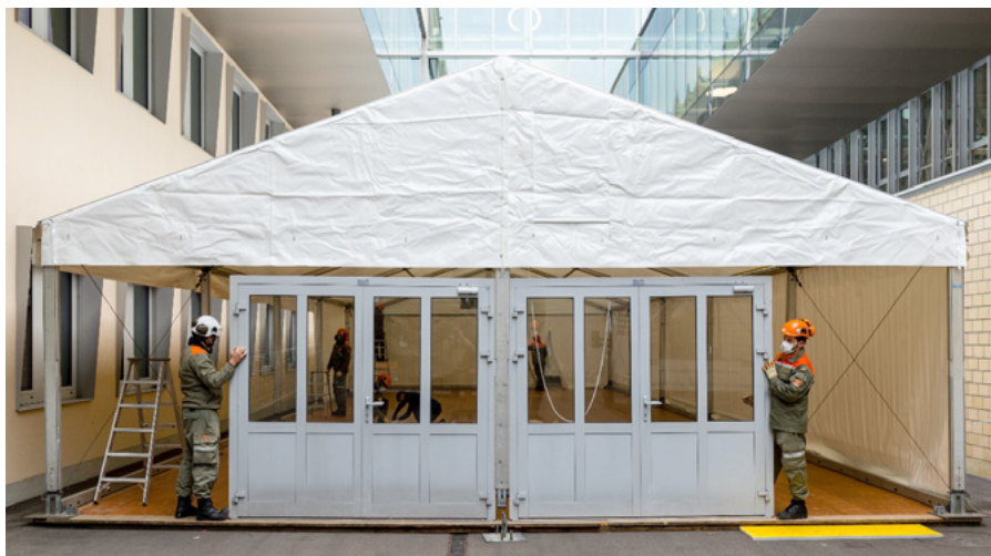
Fig.1: Montaggio di una tenda d'emergenza (Mediateca DDPS)
