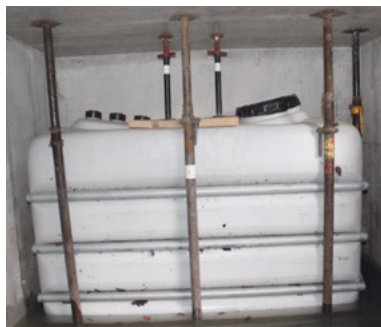
Fig. 83: Messa in sicurezza di una cisterna d'olio combustibile (Assicurazione immobiliare del Canton Berna AIB)
