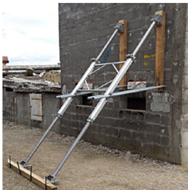
Fig.105: Semplici puntellamenti di ritegno «a stampella» con puntelli per impalcature e con puntelli regolabili (senza dormiente)
