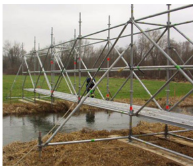
Fig. 96: Passerella autoportante di 9 metri (Technisches Hilfwerk - THW)
