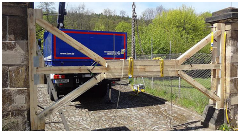
Fig. 79: Esempio di un puntellamento di contrasto (Blockhaus, Technisches Hilfwerk - THW)
