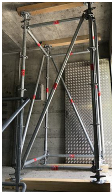
Fig. 26: Puntellamento tridimensionale
