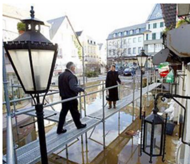
Fig. 95: Passerella costruita con ponteggi (EGS) per l'acqua alta (Technisches Hilfwerk - THW)
