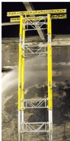
Fig.60: Puntellamenti verticali tridimensionali con impalcature edili
