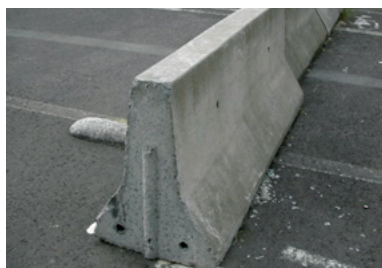
Fig. 65: Elementi di una barriera di protezione in calcestruzzo (Wikipedia)
