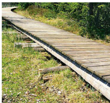
Fig. 83: Passerella appoggiata su traverse (USTRA)
