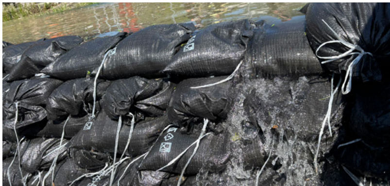
Fig. 41: Diga di sacchi di sabbia tracimata (UFPP)
