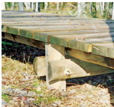
Fig. 82: Passerella appoggiata su pilastri di legno (USTRA)
