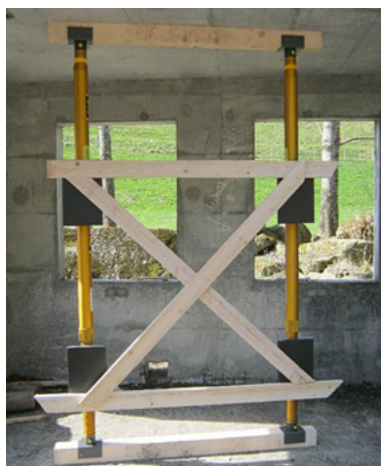
Fig. 56: Puntellamento verticale bidimensionale con puntelli del salvataggio
