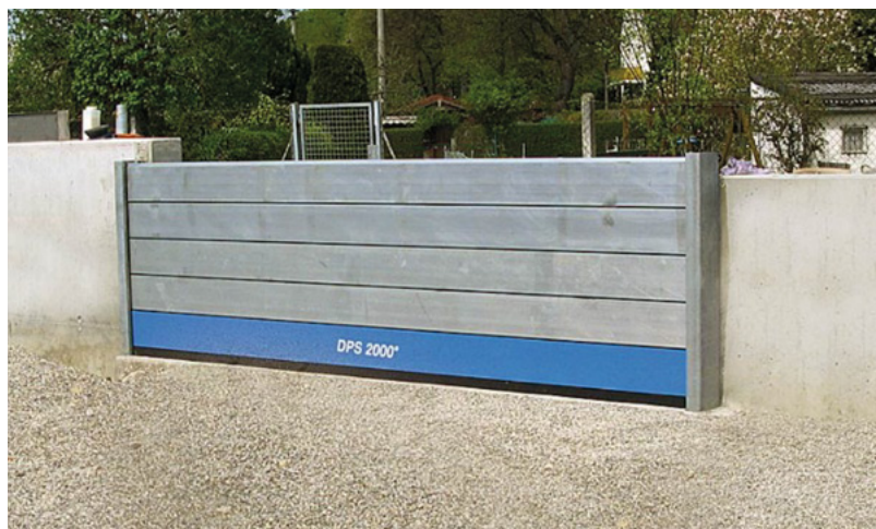
Fig. 21: Sistema a panconi (sistemi Weber di protezione contro le piene)
