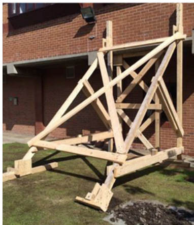
Fig.22: Puntellamento di una parete con legname (FEMA)
