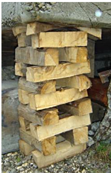
Fig. 62: Esempio di una pila instabile di listelli di legno incrociati (Regina Wenk)
