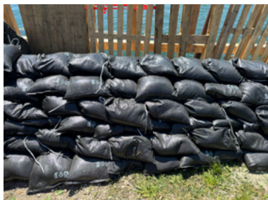
Fig. 22: Sistema con sacchi di sabbia (UFPP)
