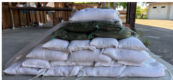
Fig. 47: Esempio di una diga normale (UFPP)
