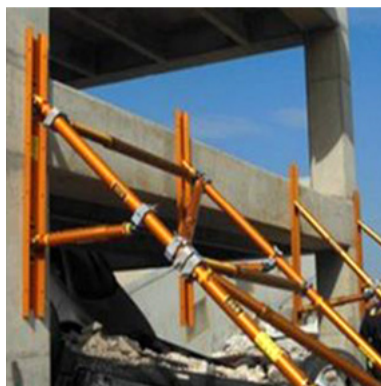
Fig.106: Puntellamenti di ritegno «a stampella» con puntelli del salvataggio (Esercito Svizzero)
