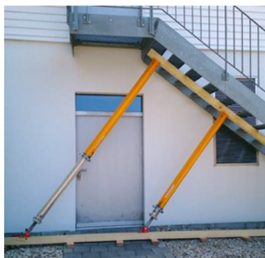
Fig.90: Puntellamento bidimensionale obliquo con puntelli dell'edilizia (metodo ortogonale)
