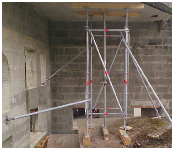
Fig.60: Puntellamenti verticali tridimensionali con impalcature edili
