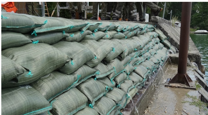
Fig. 48: Esempio di una diga regolamentare (UFPP)
