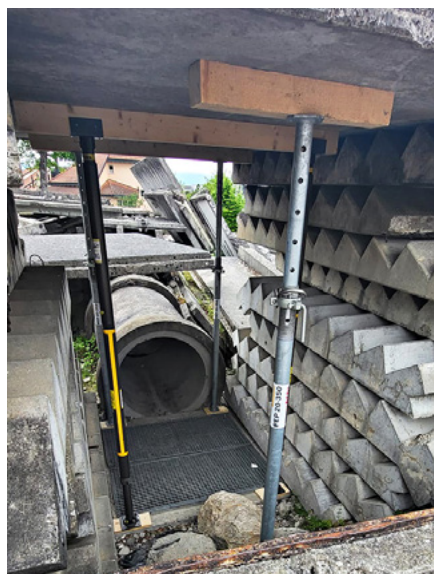
Fig. 47: Puntello singolo del salvataggio (Paratech)
