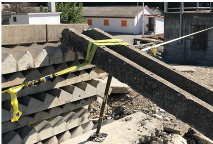
Fig. 87: Supporto rapido di un elemento costruttivo inclinato con un puntello del salvataggio e fissaggio laterale con cinghie contro lo spostamento
