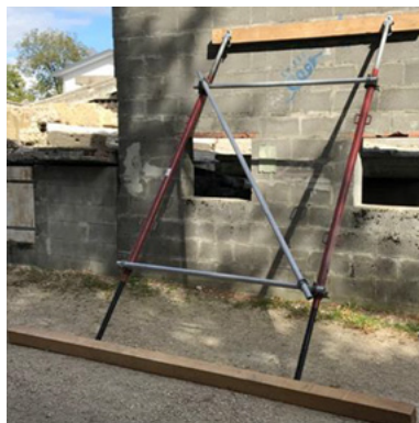
Fig.105: Semplici puntellamenti di ritegno «a stampella» con puntelli per impalcature e con puntelli regolabili (senza dormiente)
