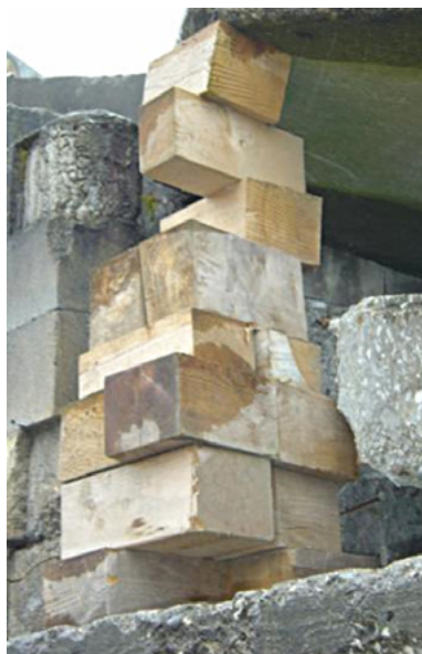
Fig. 63: Esempio di una pila instabile di listelli di legno incrociati (Regina Wenk)
