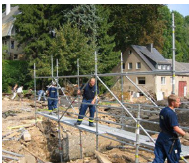
Fig. 94: Passerella costruita con ponteggi (EGS) su macerie (Technisches Hilfwerk - THW)
