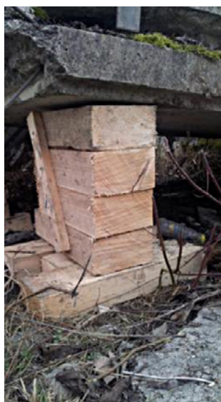
Fig. 74: Esempi di semplici pile di travetti di legno (Regina Wenk)
