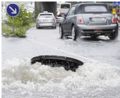
Fig. 14: Riflusso nelle canalizzazioni (Bruno Gerber, Ufficio del genio civile del Canton Berna)
