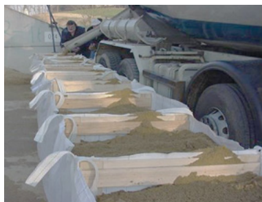
Fig. 64: Riempimento di big bag con un'autobetoniera (INN-PACK)
