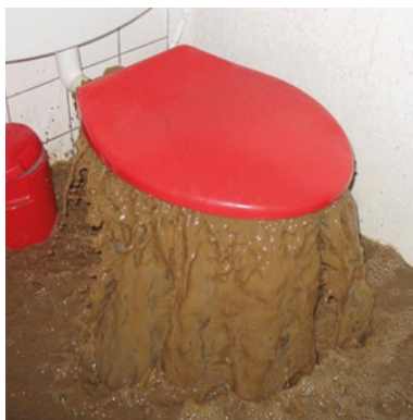
Fig. 14: Riflusso nelle canalizzazioni (Bruno Gerber, Ufficio del genio civile del Canton Berna)
