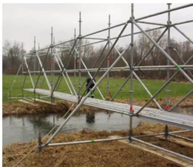
Fig.96: Passerella autoportante di 9 metri (Technisches Hilfwerk - THW)
