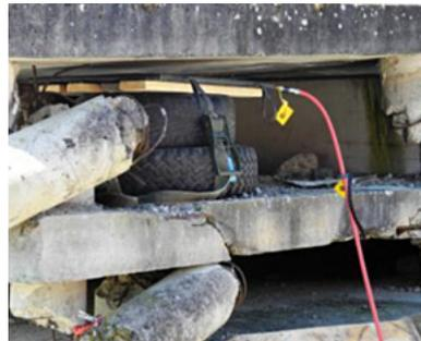
Fig. 115: Esempio di puntellamento alternativo: pneumatici riempiti di pietre, fissati con una cinghia contro lo spostamento laterale e bloccati da un cuscinio di sollevamento (Catena svizzera di salvataggio)
