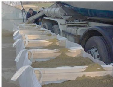
Fig. 64: Riempimento di big bag con un'autobetoniera (INN-PACK)
