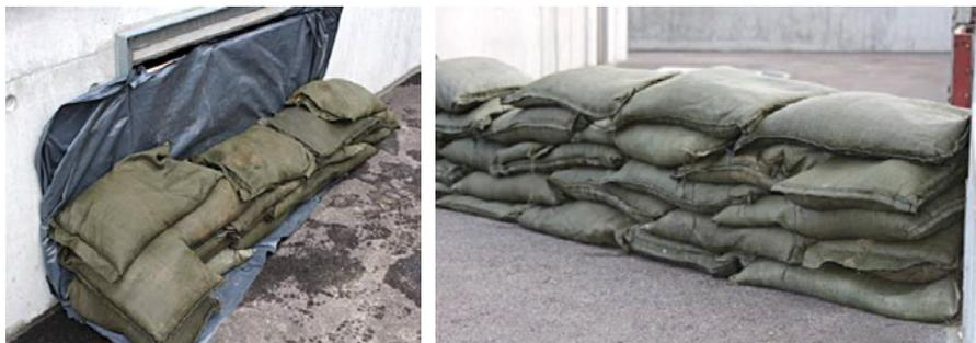
Fig. 50: Protezione di una finestra di seminterrato e di un passaggio (Assicurazione immobiliare del Canton Berna AIB)
