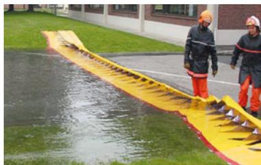
Fig. 62: Impiego di una barriera autoportante (MegaSecur Europe)
