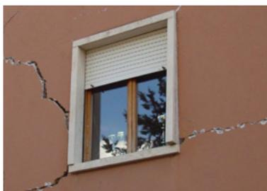
Fig. 3: Crepa in un muro di laterizio
