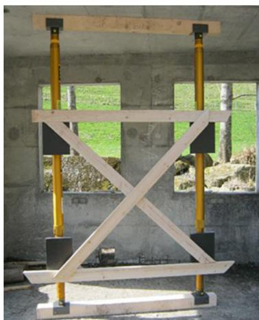
**Fig. 56: Puntellamento verticale bidimensionale con puntelli del salvataggio**
