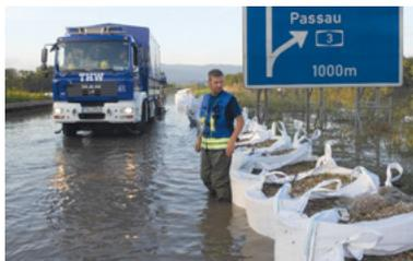
**Fig. 63: Barriera improvvisata con sacconi industriali (Technisches Hilfswerk – THW)**
