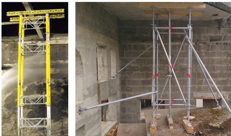
Fig.60: Puntellamenti verticali tridimensionali con impalcature edili
