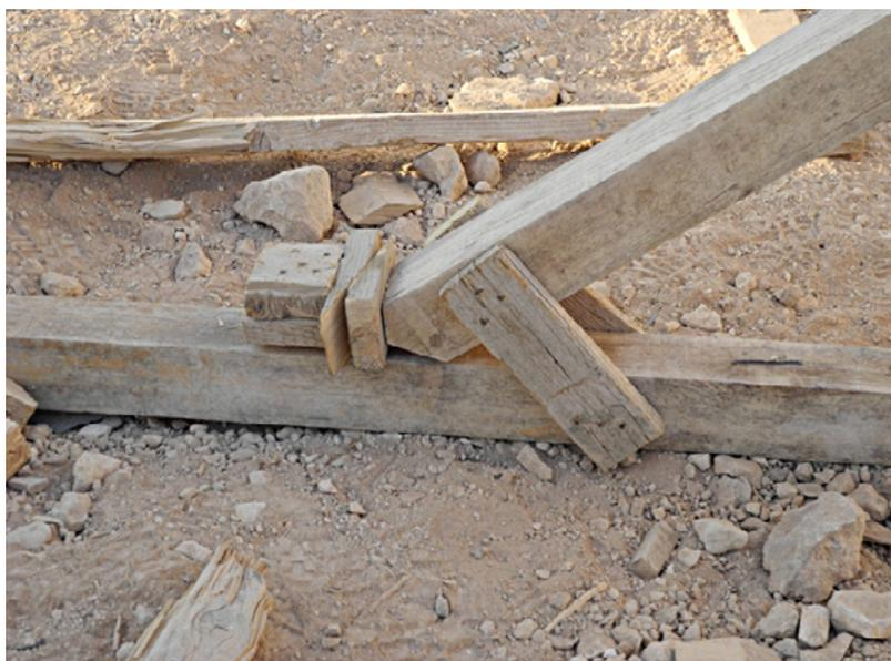
Fig.110: Puntone mal fissato sulla base d'appoggio (Regina Wenk)
