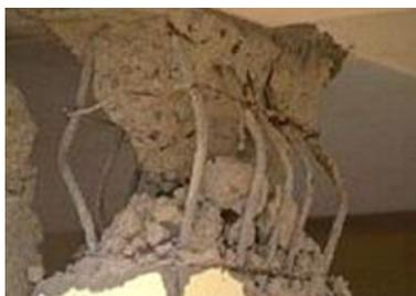
Fig. 5: Ferri da armatura scoperti
