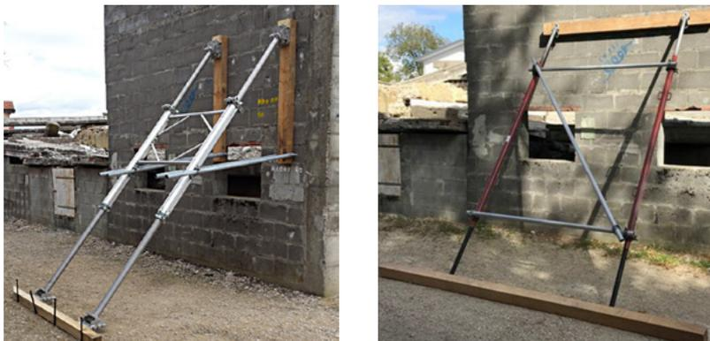
Fig.105: Semplici puntellamenti di ritegno «a stampella» con puntelli per impalcature e con puntelli regolabili (senza dormiente)
