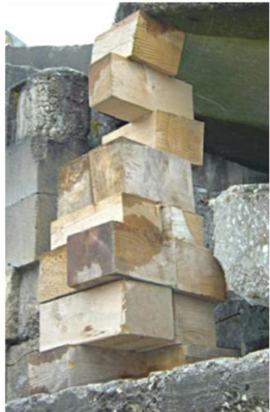
Fig. 63: Esempio di una pila instabile di listelli di legno incrociati (Regina Wenk)
