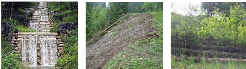
Fig.38: Opere di protezione in legno: a) sempre bagnata, b) ricoperta di terra, c) piantumata
