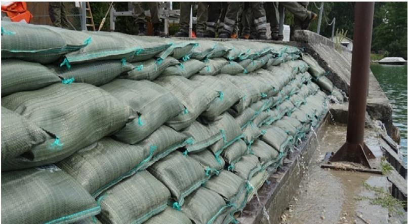
Fig. 48: Esempio di una diga regolamentare (UFPP)
