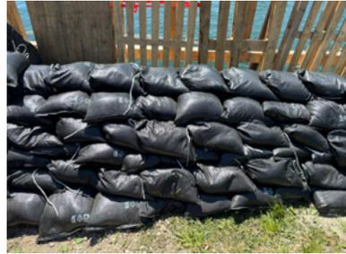
Fig. 22: Sistema con sacchi di sabbia (UFPP)
