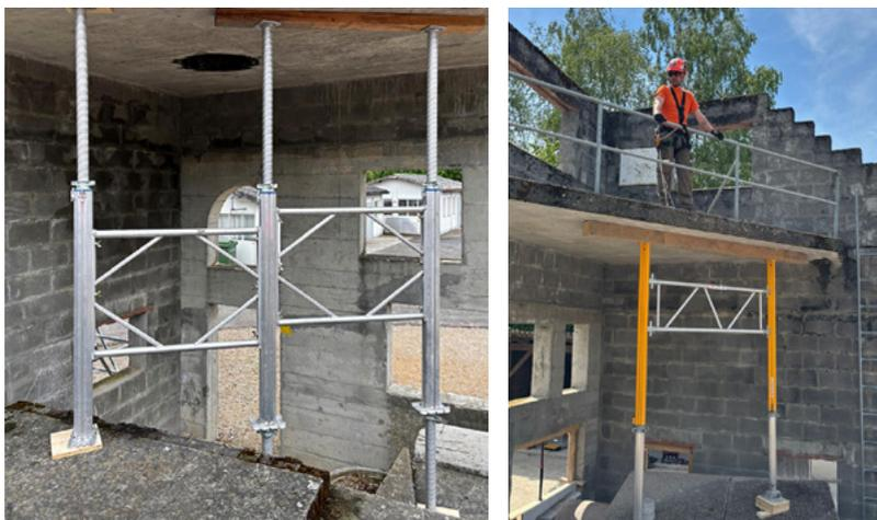
**Fig. 55: Puntellamento verticale bidimensionale con puntelli per impalcature edili (JFPP)**
