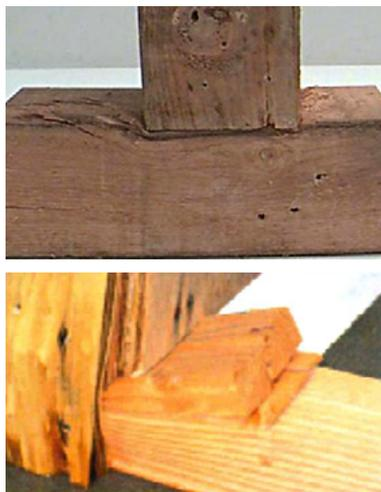
Fig. 16: Travi schiacciate dai montanti sono un segnale di sovraccarico
