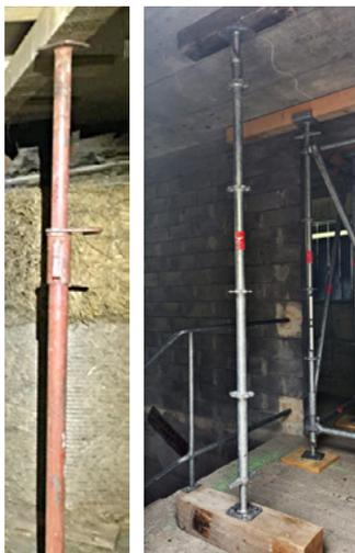
Fig. 46: Puntelli singoli dell'edilizia (Blockhaus, Technisches Hilfswerk - THW)
