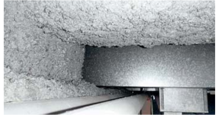
Amianto spruzzato come rivestimento antincendio su travi di acciaio
