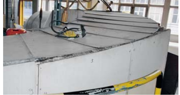
Isolamento posto dietro un rivestimento
