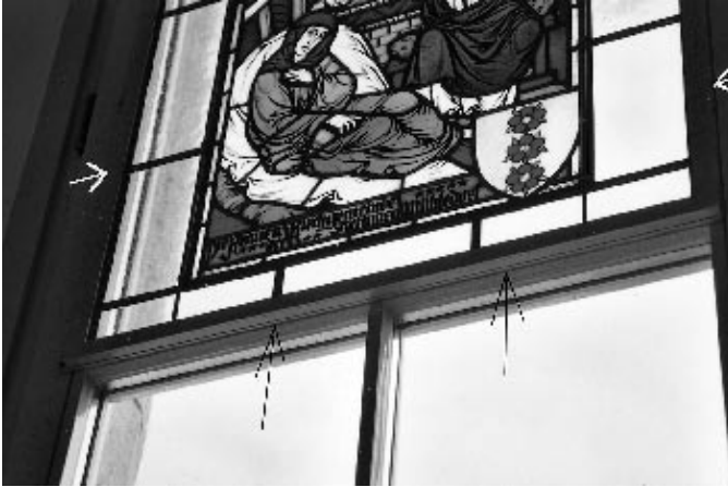
Abb. 12: Reformierte Kirche Mühledorf (SO), Chor / Innenansicht: Integrierte Farbfenster-Einlagen (Holzsprossen-Einteilung) in Kombination mit einer isothermischen Schutzverglasung. Die Detailaufnahme zeigt die Gewährleistung einer umfassenden Hinterlüftung (mit Pfeilen gekennzeichnet). Foto: Atelier Halter.
