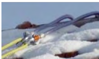
Ancoraggio alla linea di colmo
