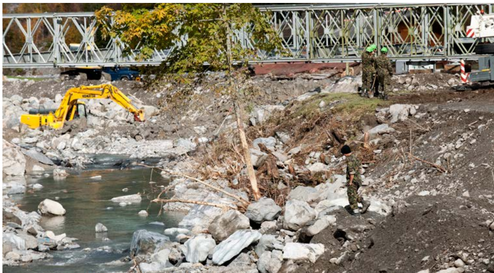
Figura 5: Costruzione di un ponte d'emergenza nella zona colpita
