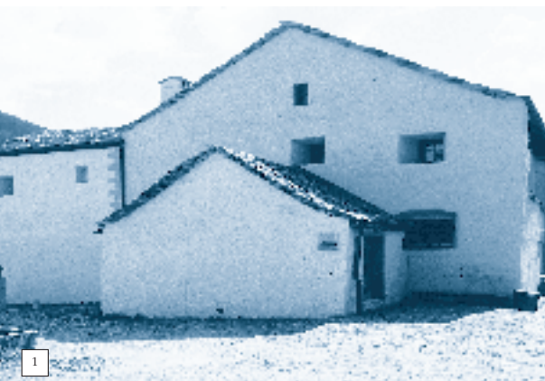
1 Der «Alte Gasthof» in Simplon-Dorf, das Zentrum des Ecomuseums Simplon, entstand in mehreren Bauetappen zwischen dem 14. und dem 18. Jahrhundert. Foto: Klaus Andereg, Binn.
