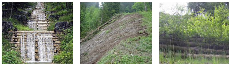
Fig.38: Opere di protezione in legno: a) sempre bagnata, b) ricoperta di terra, c) piantumata
