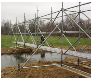
Fig. 96: Passerella autoportante di 9 metri (Technisches Hilfwerk – THW)
