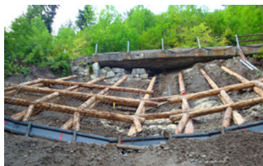
Fig. 71: Griglia con tronchi distanziatori intermedi (Studio d'ingegneria civile Ammann SA)
