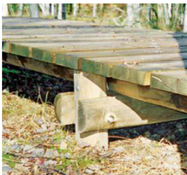
Fig. 82: Passerella appoggiata su pilastri di legno (USTRA)
