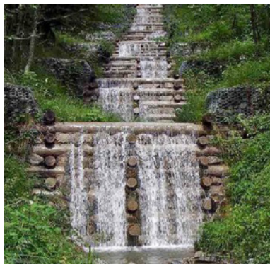
Fig.46: Gradinata di briglie esempio (waldwissen)
