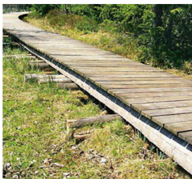
Fig. 83: Passerella appoggiata su traverse (USTRA)
