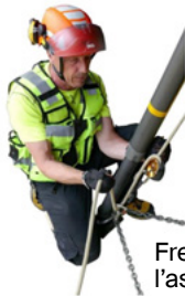
Fig.71: Calare una barella mediante un treppiede per carichi pesanti e un paranco universale (immagine senza dispositivo anticaduta)
