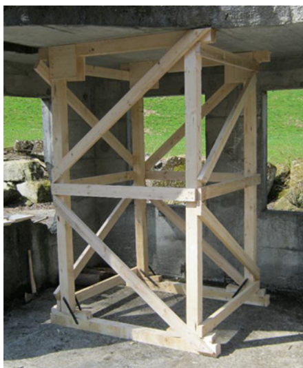
Fig.59: Esempio di un puntellamento verticale tridimensionale in legno
