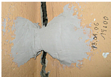
Fig.18: Monitoraggio della crepa con un sigillo di gesso
