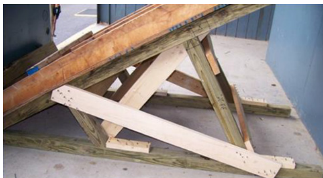
Fig. 92: Puntellamento tridimensionale obliquo in legno (metodo ortogonale) (FEMA)
