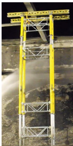
Fig.60: Puntellamenti verticali tridimensionali con impalcature edili
