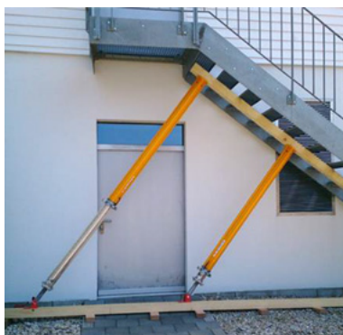
Fig. 90: Puntellamento bidimensionale obliquo con puntelli dell'edilizia (metodo ortogonale)
