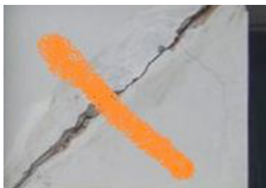
Fig.17: Monitoraggio della crepa con un tratto colorato (Regina Wenk)
