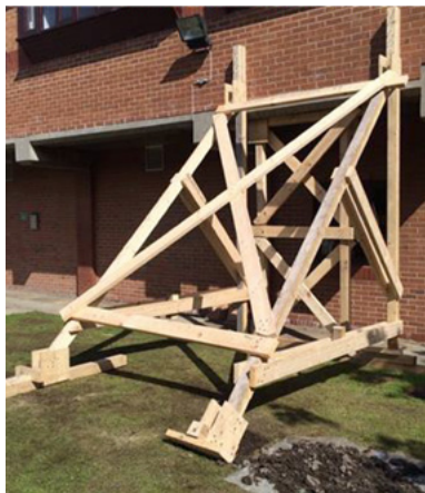
Fig.22: Puntellamento di una parete con legname (FEMA)
