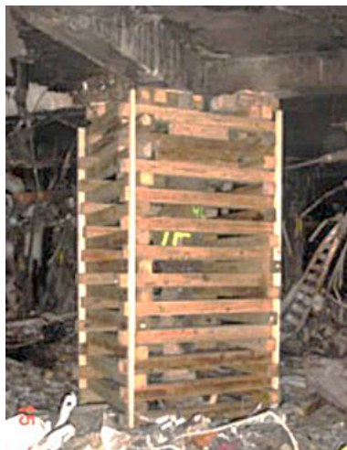
Fig. 69: Puntellamento con una pila di listelli di legno incrociati al Pentagono dopo l'attacco terroristico (FEMA)
