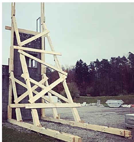
Fig. 109: Esempio di un puntellamento di ritegno triangolare in legno con quattro puntoni (OPC Turgovia)
