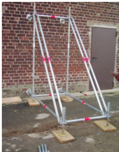
Fig.111: Puntellamenti di ritegno triangolari con puntelli per impalcature (THW)
