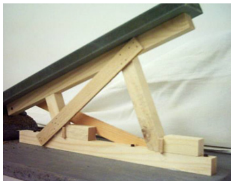
Fig. 89: Modello di un puntellamento bidimensionale obliquo in legno (metodo ortogonale) (Blockhaus, Technisches Hilfwerk – THW)
