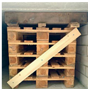
Fig. 71: Esempio di una pila di palette costruita correttamente (Blockhaus, Technisches Hilfwerk – THW)
