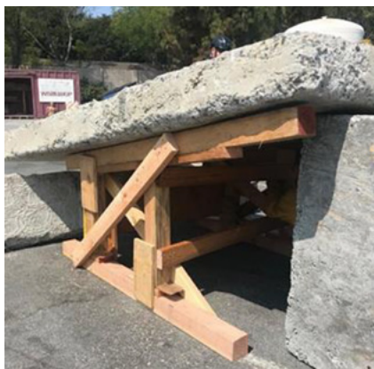
Fig. 95: Puntellamento tridimensionale obliquo in legno (metodo verticale) (FEMA)
