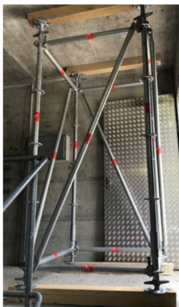
Fig. 26: Puntellamento tridimensionale
