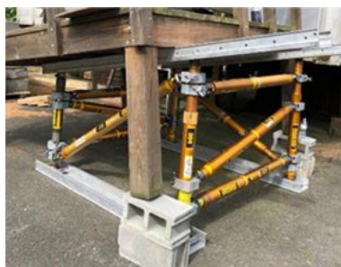
Fig. 96: Puntellamento tridimensionale obliquo con puntelli del salvataggio (metodo verticale) (Paratech)
