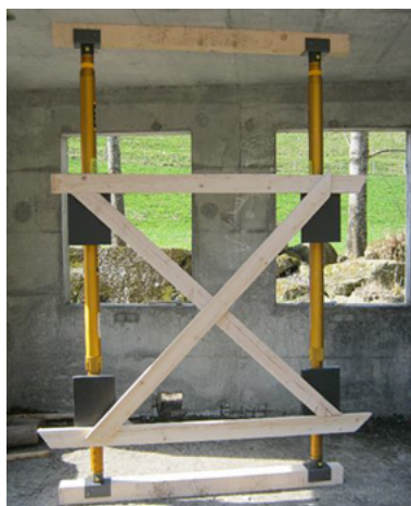
Fig. 56: Puntellamento verticale bidimensionale con puntelli del salvataggio
