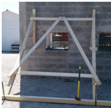
Fig.104: Esempio di un puntellamento di ritegno «a stampella» in legno
