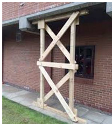
Fig. 54: Esempio di puntellamento verticale bidimensionale in legno (FEMA)
