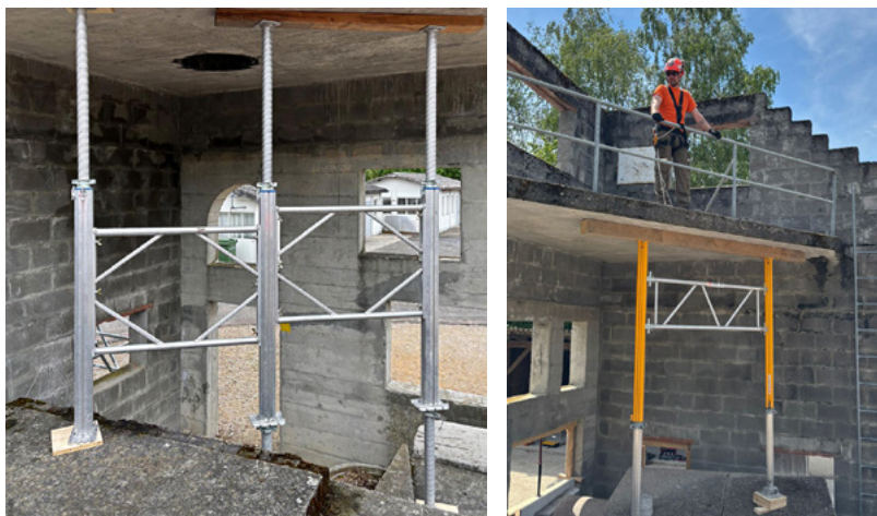
Fig. 55: Puntellamento verticale bidimensionale con puntelli per impalcature edili (UFPF)
