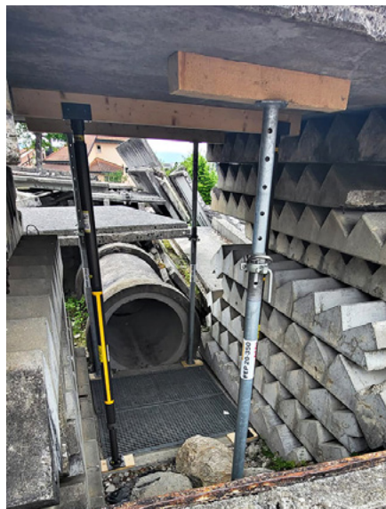
Fig. 47: Puntello singolo del salvataggio (Paratech)
