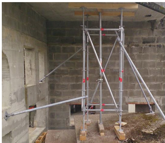
Fig.60: Puntellamenti verticali tridimensionali con impalcature edili
