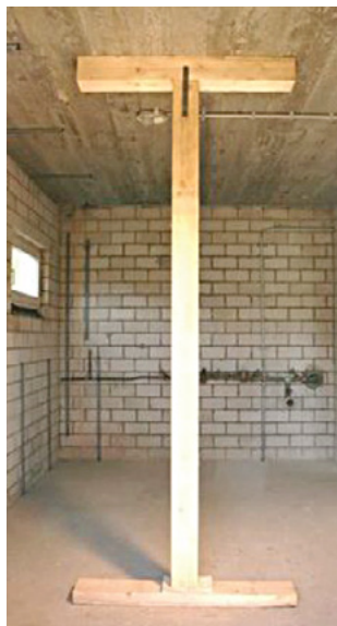
Fig. 45: Puntello verticale di legno
