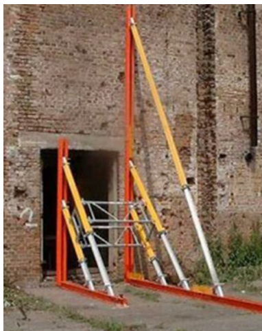
Fig.111: Puntellamenti di ritegno triangolari con puntelli per impalcature (THW)
