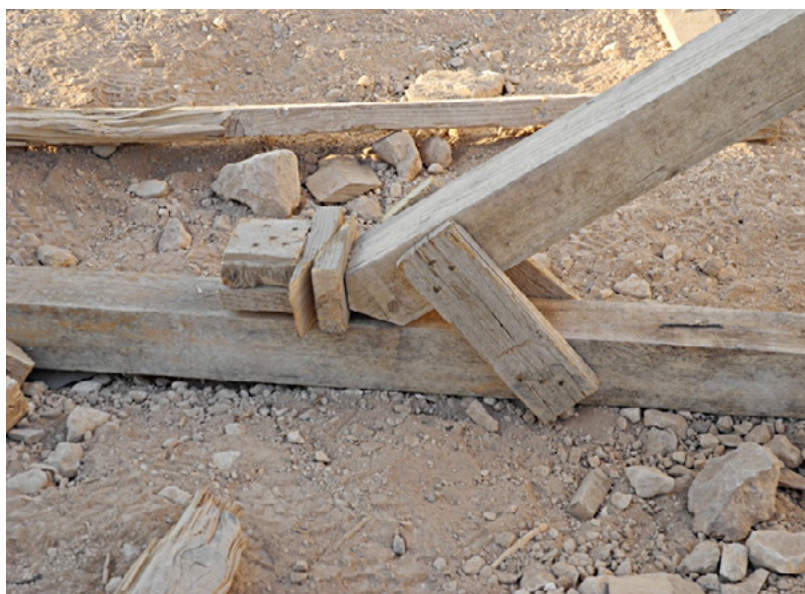
Fig. 110: Punterone mal fissato sulla base d'appoggio (Regina Wenk)
