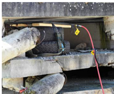
Fig.115: Esempio di puntellamento alternativo: pneumatici riempiti di pietre, fissati con una cinghia contro lo spostamento laterale e bloccati da un cuscino di sollevamento (Catena svizzera di salvataggio)
