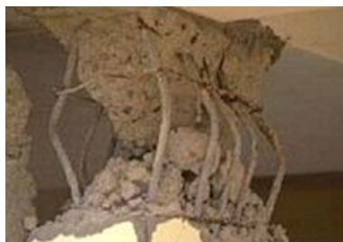
Fig. 5: Ferri da armatura scoperti
