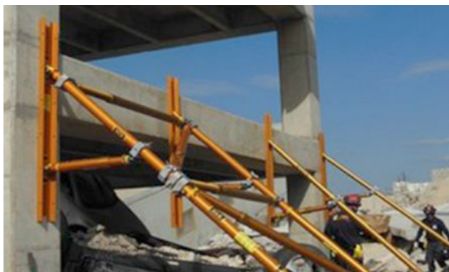
Fig. 27: Puntellare con puntelli di soccorso multifunzionali (Paratech)
