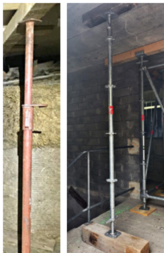
Fig. 46: Puntelli singoli dell'edilizia (Blockhaus, Technisches Hilfswerk – THW)
