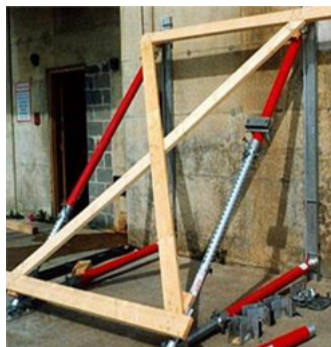
Fig.112: Puntellamenti di ritegno triangolari con puntelli del salvataggio (Paratech/Airshore)
