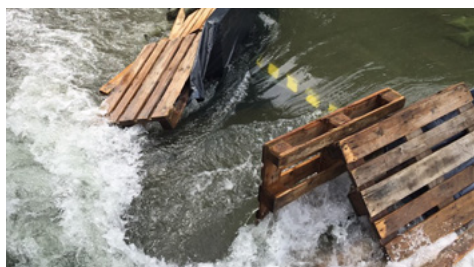
Fig. 59: Paratia con palette trascinata via dalla corrente (UFPP)
