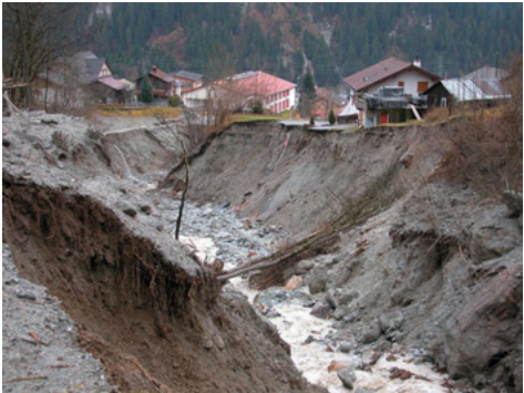
Fig. 9: Erosione delle sponde e in profondità a Rueun GR (Piattaforma nazionale Pericoli naturali PLANAT)
