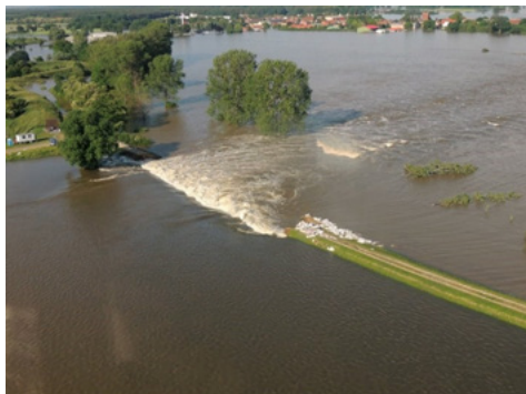
Fig. 68: Rottura di un argine (Robert Jüpner, Università tecnica di Kaiserslautern)
