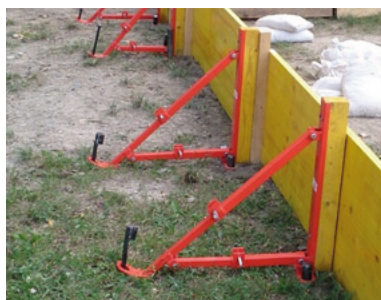
Supporto con puntelli regolabili per casseforme
