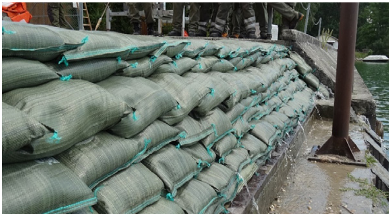
Fig. 48: Esempio di una diga regolamentare (UFPP)
