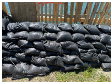
Fig. 22: Sistema con sacchi di sabbia (UFPP)
