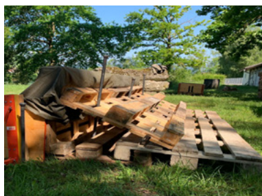
Fig. 60: Paratia realizzata con tre palette (Assicurazione immobiliare del Canton Berna AIB) e con quattro palette (UFPP)
