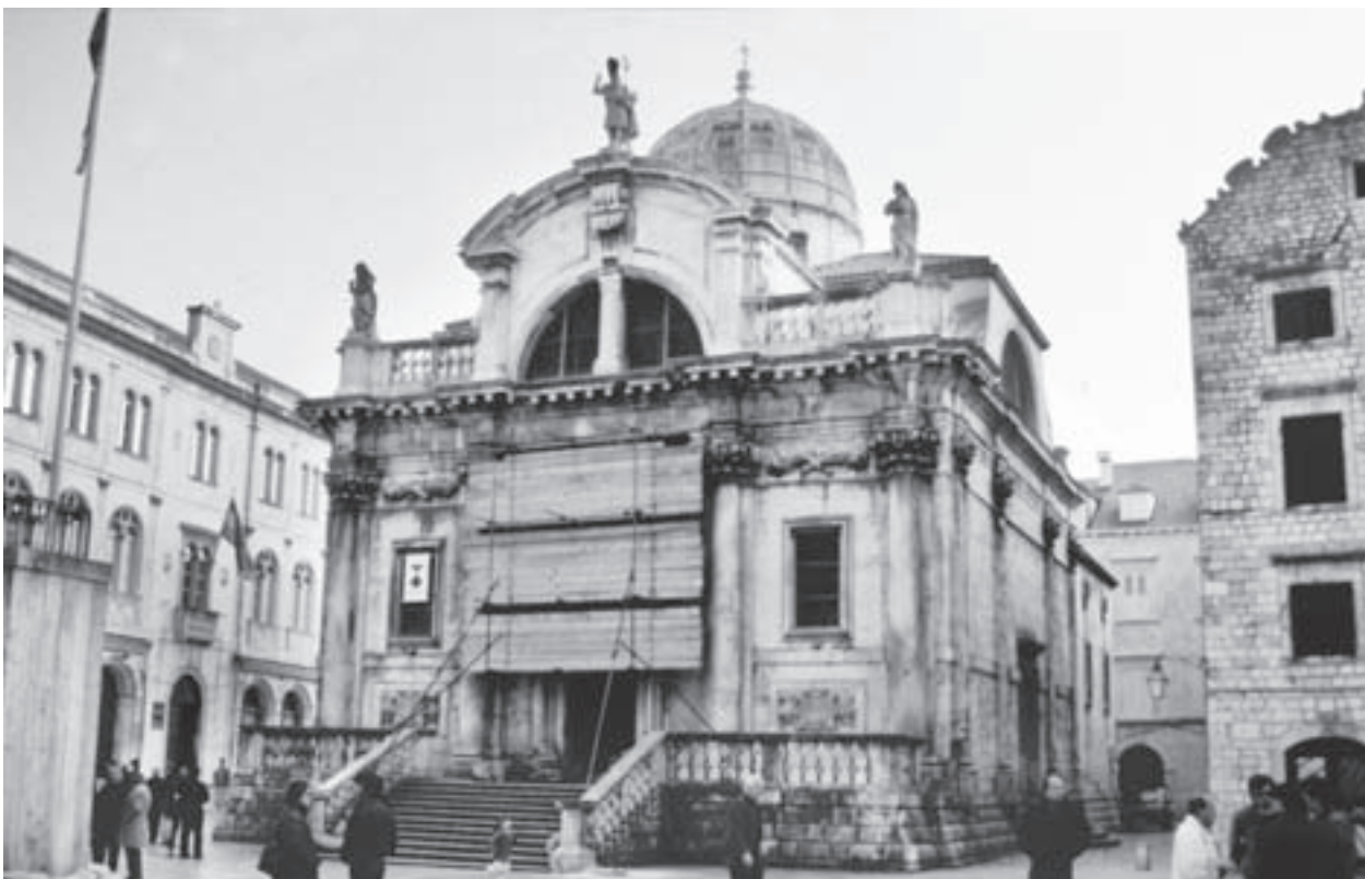
Fig. 3: Das Portal der Kirche St. Blaise wurde mit einer Holzkonstruktion geschützt und mit dem KGS-Schild als schutzwürdiges Objekt gekennzeichnet. Foto: © UNESCO; Hyvert, G.
