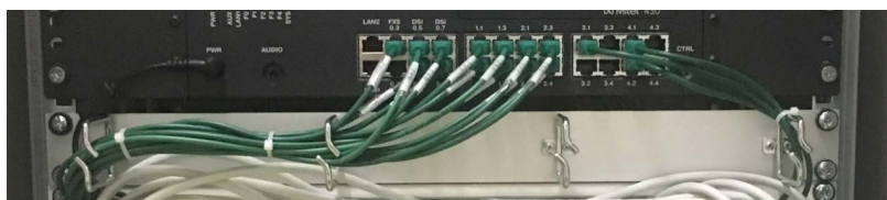
Fig. 6: parte frontale Mitel 430 con porte per raccordi esterni
