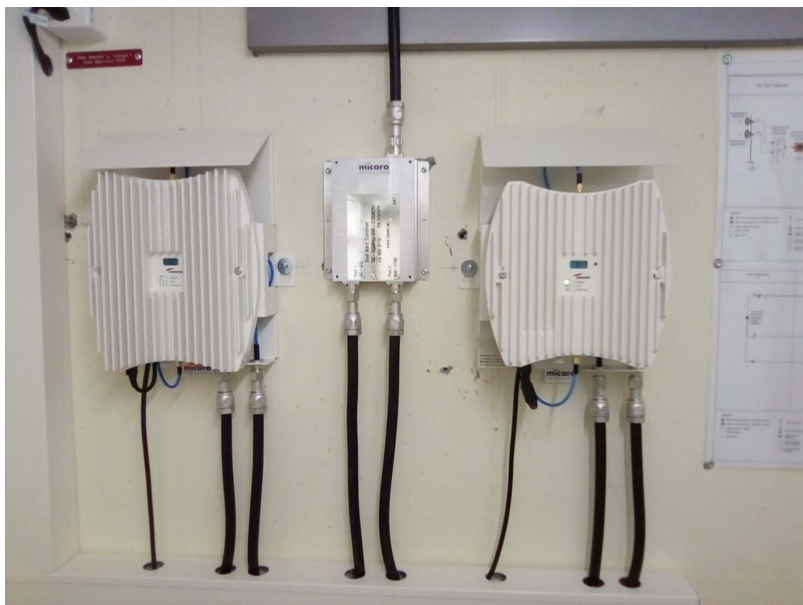
Fig.16: esempio di un ripetitore Polycom a banda larga attivo (a sinistra), di un duplexer (al centro) e di un ripetitore a banda larga per la telefonia mobile (a destra)
