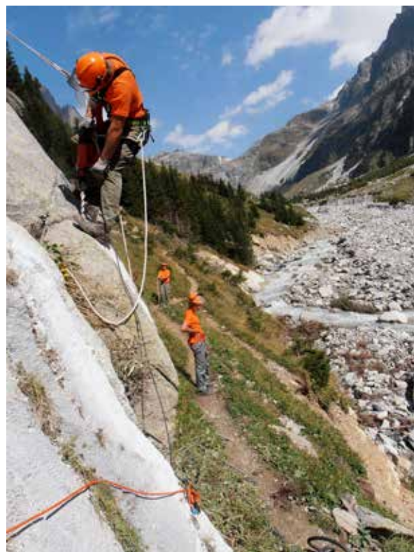
Nel settembre del 2012 l'OPC Gantrisch è intervenuta nella valle di Gastern per ripristinare i danni causati dalla piena del fiume Kander nel 2011. Grazie alla prontezza operativa accresciuta, in futuro il Canton Berna sarà in grado di pianificare meglio gli interventi rapidi.
