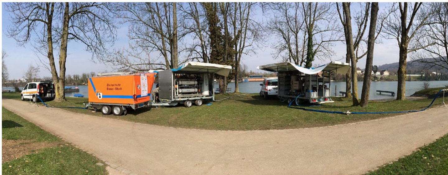
Un impianto di trattamento mobile può produrre acqua potabile per 40'000 persone.
