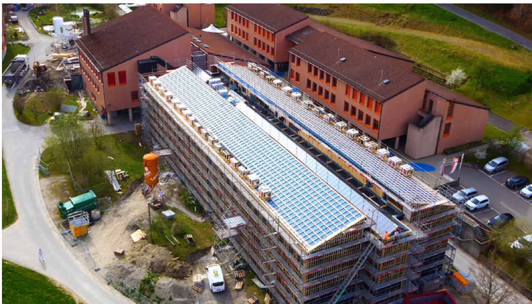
▲ Ristrutturazione dell'edificio B. © UFPP
