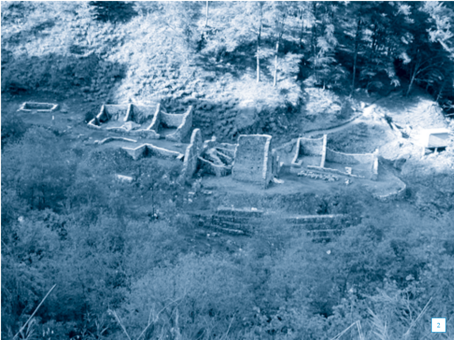
2 Maglio e forno di Carena dopo il restauro – vista della strada agroforestale. Foto: © Christian Bordoli.
