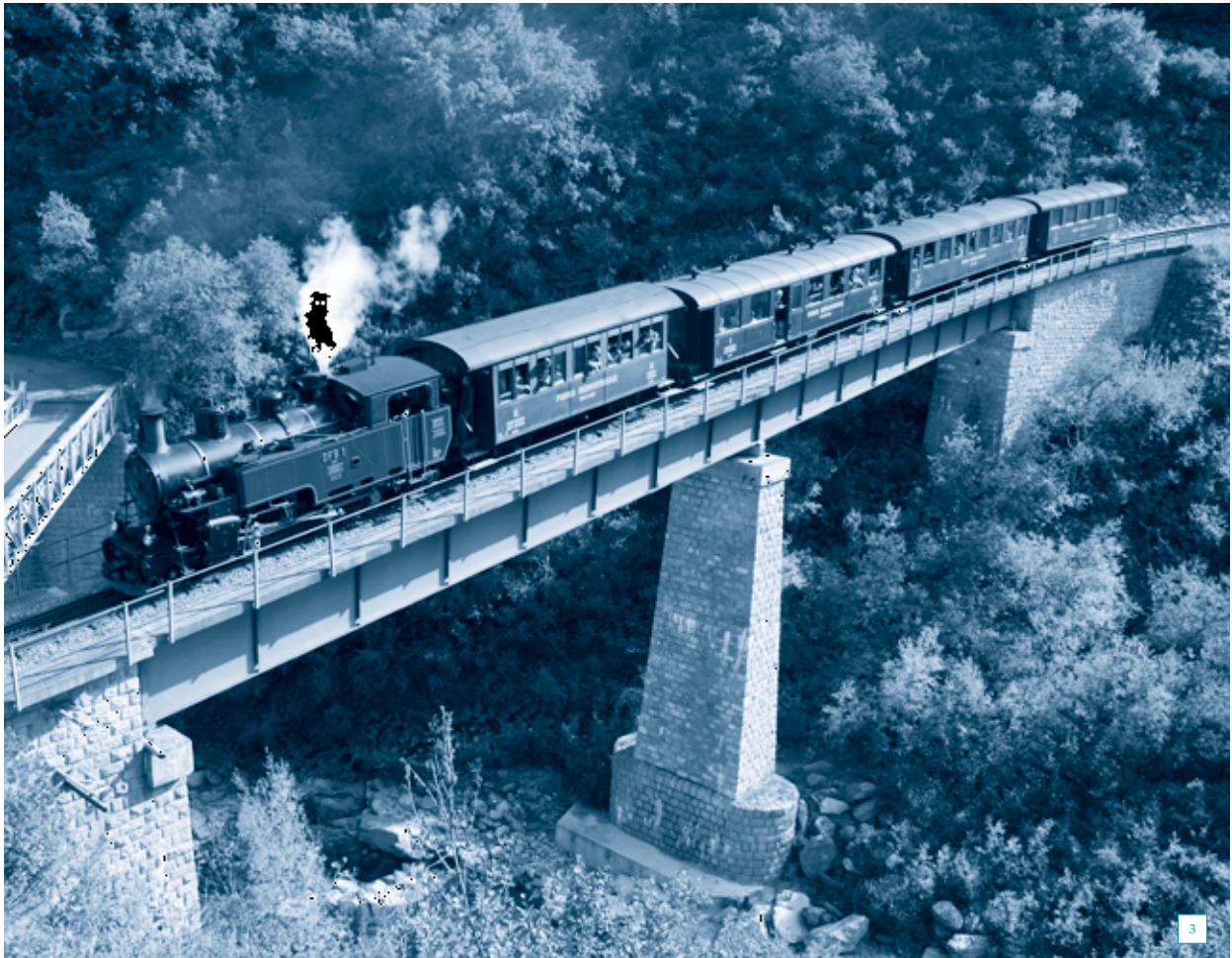
3 Bild oben: Etliche Kunstbauten wie hier die Wylerbrücke bei Realp sind Bestandteil der Strecke und benötigen entsprechenden Unterhalt. Foto: © DFB, Dampfbahn Furka-Bergstrecke.
