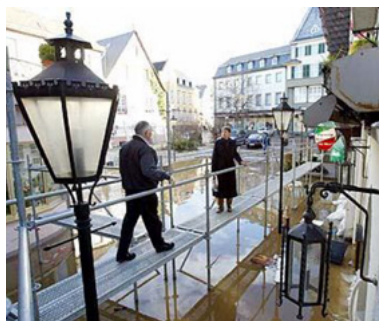
Fig.95 : Passerelle EGS en cas de crue (THW)
