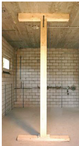
Fig. 45 : Étais vertical en bois (Blockhaus, THW)
