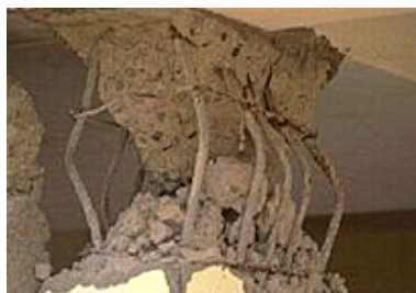
Fig.5 : Fers d'armure exposé
