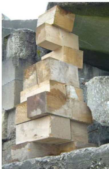
Fig. 63 : Exemple d'une pile de bois croisée instable (Regina Wenk)
