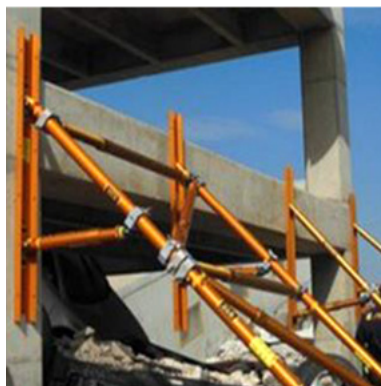
Fig. 106 : Contrefichages au moyen d'un système d'étais du secteur du sauvetage
