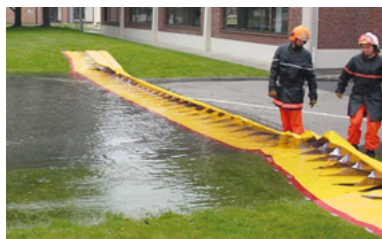
Fig. 62 : Système de barrière déployable en intervention (MegaSecur Europe)
