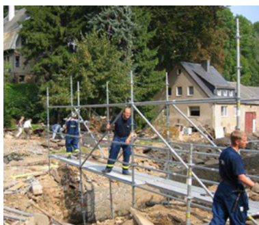
Fig.94 : Passerelle EGS enjambant des décombres (THW)
