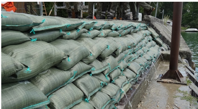
Fig. 48 : Exemple d'une digue réglementaire (OFPP)
