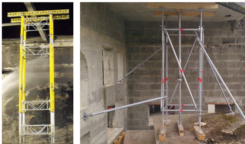
Fig. 60 : Charpentes verticales tridimensionnelles constituées d'un système d'étais et de matériel d'échafaudage
