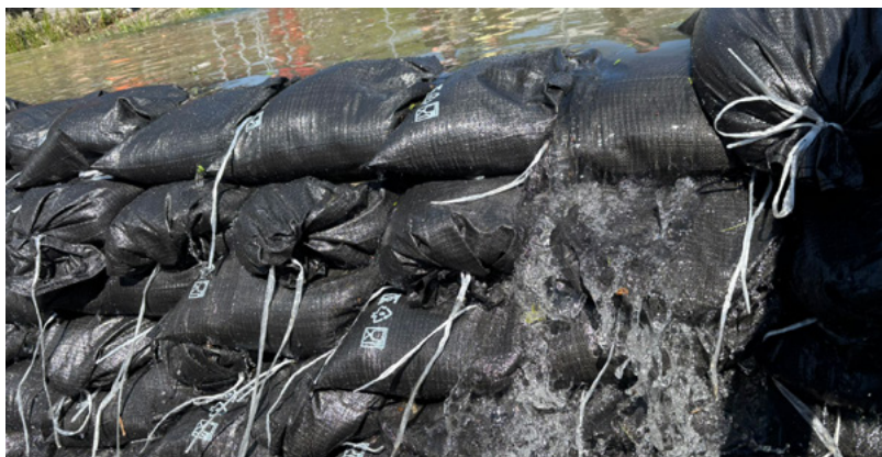
Fig. 41 : Digue de sacs de sable débordée (OFFPP)
