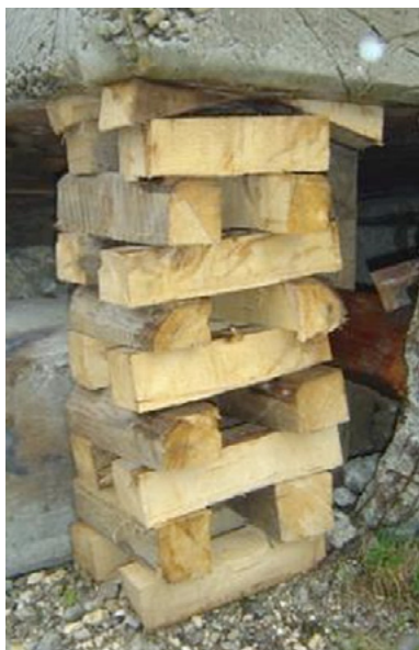
Fig. 62 : Exemple d'une pile de bois croisée instable (Regina Wenk)
