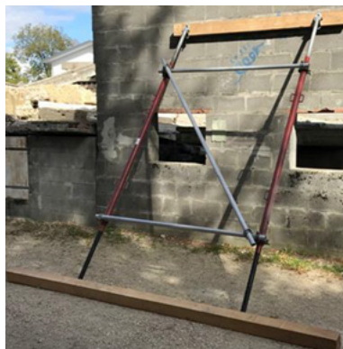
Fig. 105 : Contrefichages simples au moyen d'un système d'étais et d'étais de réglage (sans lambourdes) du secteur de la construction
