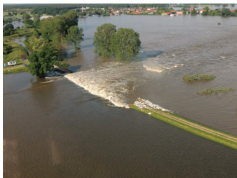
Fig. 68 : Rupture d'une digue (Robert Jüpner, Université technique de Kaiserslautern).
