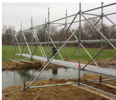
Fig.96 : Passerelle autoportante d'une portée de 9 mètres (THW)
