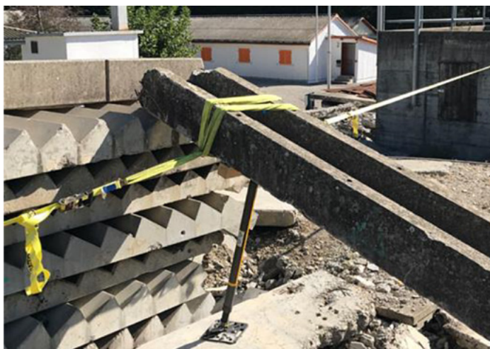
Fig. 87 : Sécurisation rapide d'un élément de construction incliné à l'aide d'un étai de sauvetage et d'un haubanage latéral au moyen de sangles d'arrimage pour empêcher le déplacement
