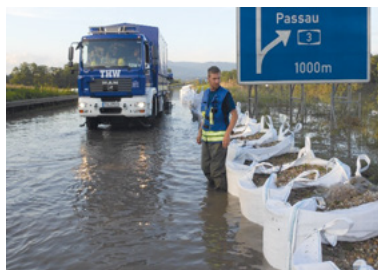
Fig. 63 : Système improvisé de réservoirs avec des sacs industriels (THW)
