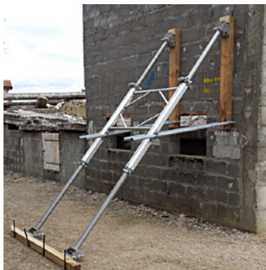
Fig. 105 : Contrefichages simples au moyen d'un système d'étais et d'étais de réglage (sans lambourdes) du secteur de la construction
