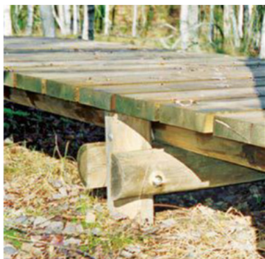
Fig. 83 : Passerelle sur pilotis (OFROU)
