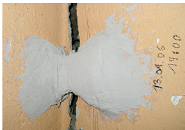
Fig. 18 : Scellement de plâtre sur une fissure
