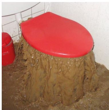
Fig.14 : Reflux par les égouts (Bruno Gerber, Office des ponts et chaussées du canton de Berne)
