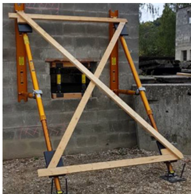
Fig. 106 : Contrefichages au moyen d'un système d'étais du secteur du sauvetage
