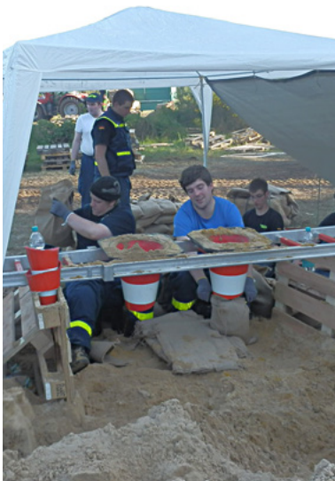
Fig. 35 : Cônes de balisage avec échelle (THW)
