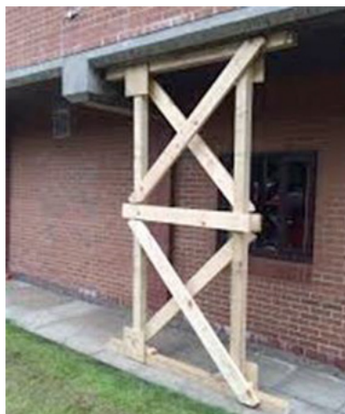
Fig. 54 : Exemple d'une charpente plane en bois (FEMA)
