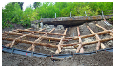
Fig. 71 : Treillage avec entretoises (Ammann Ingenieurbüro AG)
