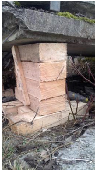
Fig. 74 : Exemples de piles de bois équarri simples (Regina Wenk)
