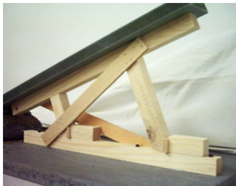
Fig. 89 : Modèle d'une charpente plane inclinée en bois (méthode à angle droit) (Blockhaus, THW)
