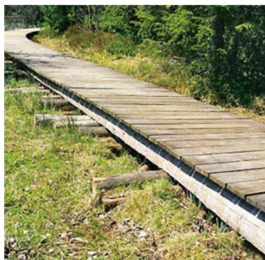
Fig. 84 : Construction avec des poutres transversales (OFROU)
