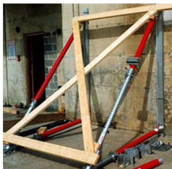
Fig.112 : Contreforts combinés avec un système d'étagage du secteur du sauvetage (Paratech / Airshore)
