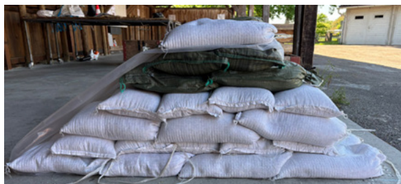
Fig. 47 : Montage d'une digue normale (OFPP)
