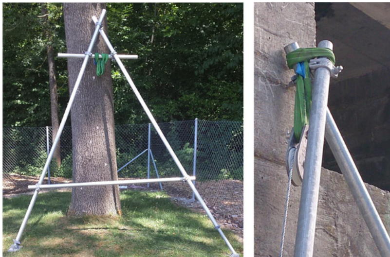
Fig. 52 : Exemples de bipieds réalisés avec des barres d'échafaudage
