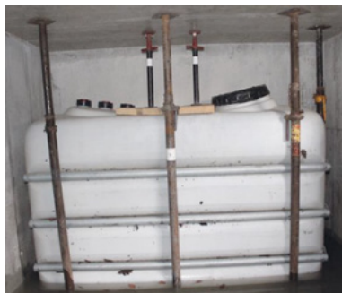
Fig. 83 : Mise en sécurité d'une cuve à mazout (AIB)
