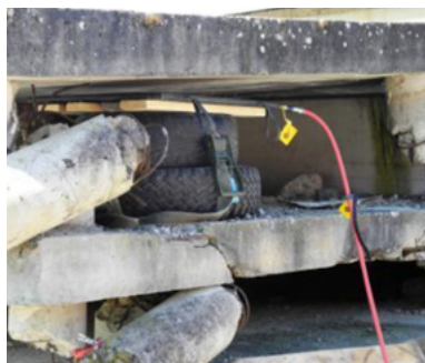
Fig. 115 : Exemple d'étaisage improvisé : pneus remplis de pierres, protégés contre le déplacement latéral par des sangles d'arrimage et bloqués par des coussins de levage (Chaîne suisse de sauvetage)
