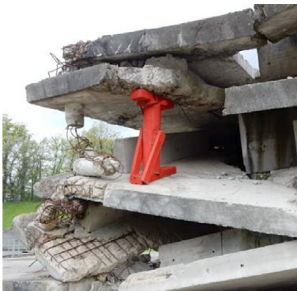
Fig. 49 : Support très dangereux et inutilisable pour une dalle en porte-à-faux (Chaîne suisse de sauvetage)
