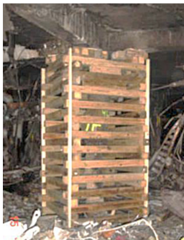
Fig. 69 : Étayage au moyen d'une pile de bois croisé au Pentagone après l'attaque terroriste (FEMA)
