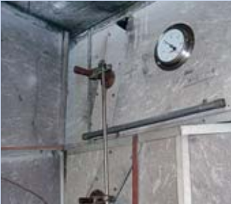
Installation de ventilation en fibrociment
