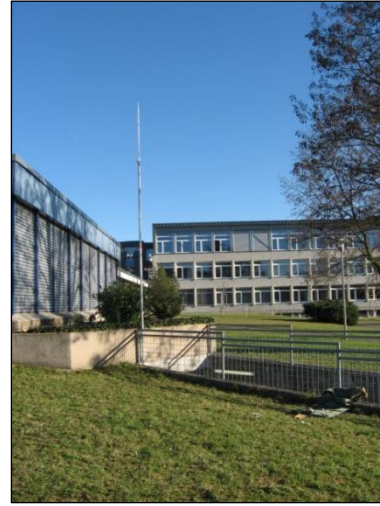
Fig. 4 Antenne SEA 400S séparée, dans l'aire d'entrée
