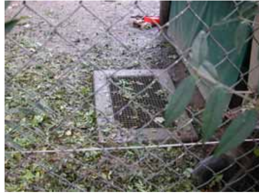
Abbildung 3.8: Notausstiegsschacht
