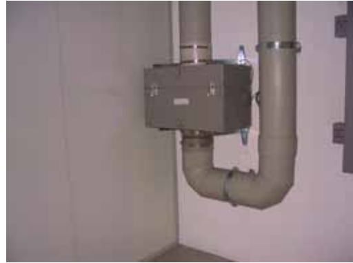
Abbildung 3.14: Spezielles Filtersystem für die Kapellenabluft.
