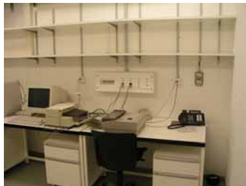
Abbildung 3.21: In jedem Raum sind grosse Steckdosenleisten installiert.
