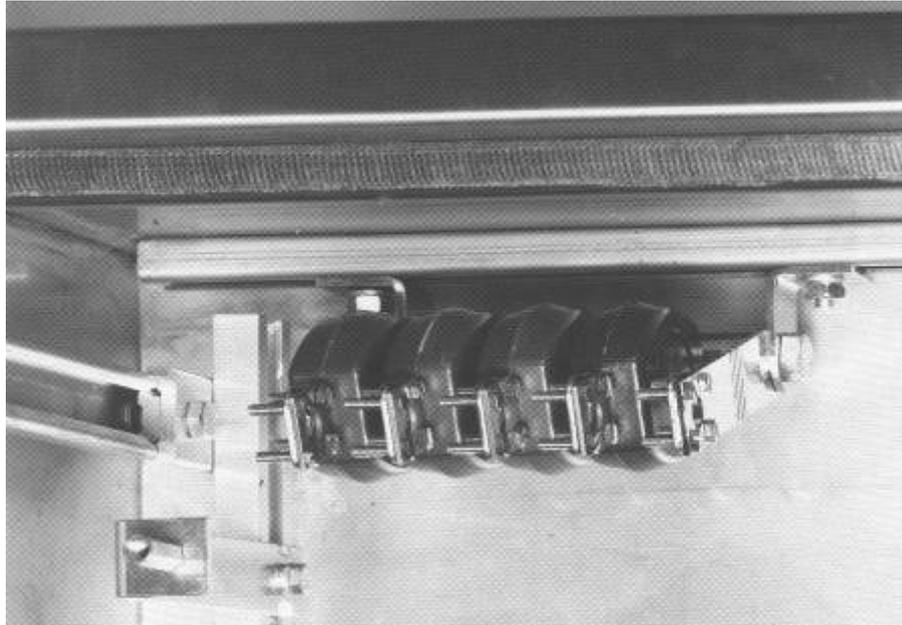
Figure 87 Support avec 4 parasurtensions MVR 0,44, monté
