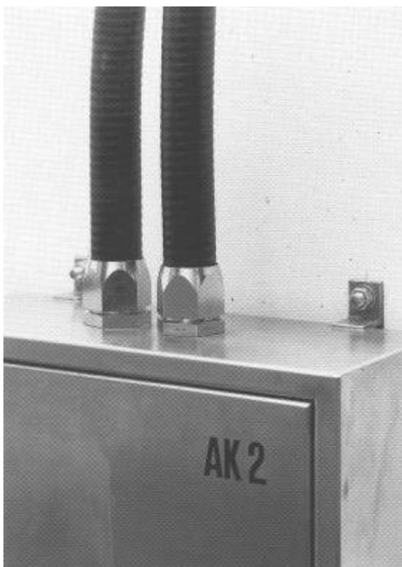
Figure 24 Raccord fileté pour tube EMP, fixé au tableau de distribution
