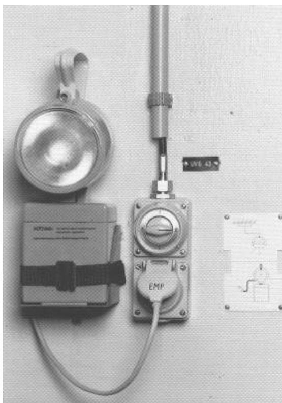
Figure 75 Combinaison interrupteur et prise pour récepteur d'énergie protégé EMP (prise pour lampe portative de secours, interrupteur pour lampe scialytique)
