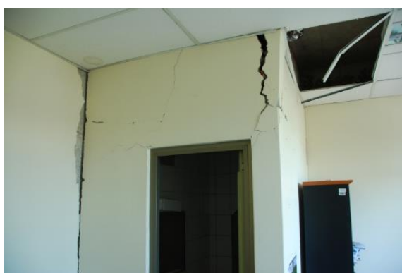
Figure 2-64. Murs non porteurs avec fixations insuffisantes menacent les environs immédiats (dans la pièce voisine une construction identique a enseveli une place de travail lors son effondrement). Le risque peut être éliminé en enlevant les parois. 37
