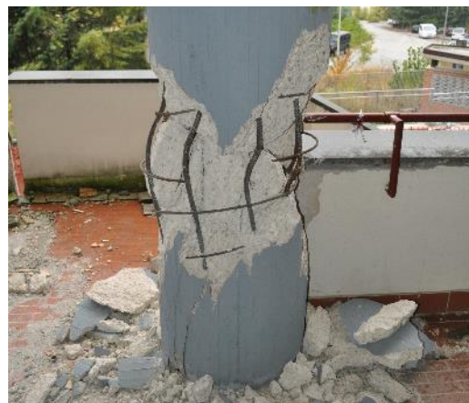
Abb. 2-39. Colonne captive : dommages provoqués par le parapet accolé au pilier 32
