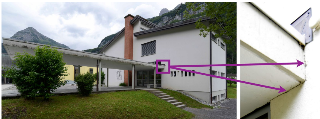
Figure IV-3. Tremblement de terre à Linthal dans le canton de Glaris en 2017. École de Linthal avec de fines fissures dans le mur de façade au niveau du support du lourd auvent en béton armé : degré de dommage 1
