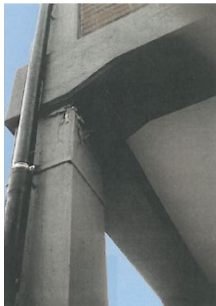
Figure 2-56. Eclatement du béton, fissures verticales (Babnolo, RE, 1996); D2-3 36
