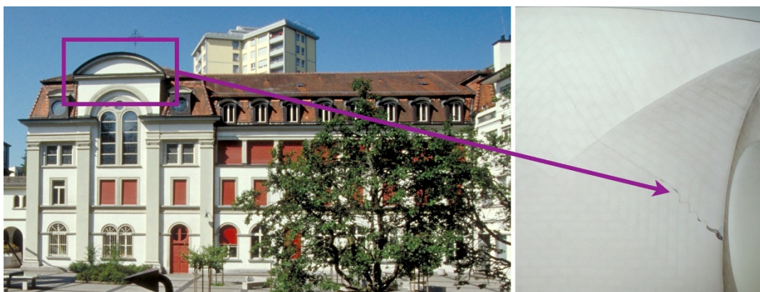
Figure IV-6. Tremblement de terre de Fribourg en 1999. Bâtiment scolaire de la ville de Fribourg présentant une fissure dans la voûte du toit en maçonnerie : degré de dommage 2
