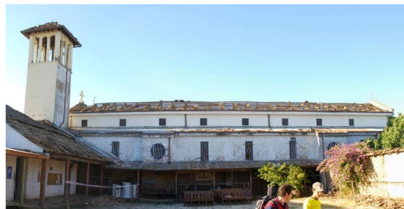
Figure 2-61. L'absence de tuiles permet la pénétration de l'eau à l'intérieur de la construction et engendre un risque d'accumulation d'eau au niveau du faux-plafond du plancher supérieur et un risque d'effondrement de ce dernier. 37
