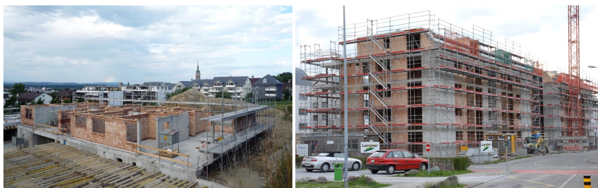
Figure II-11. Exemples de bâtiments modernes en construction mixte béton armé et maçonnerie de Suisse orientale, où les murs porteurs en béton armé traversant tous les étages jouent le rôle principal dans le transfert des sollicitations sismiques.
