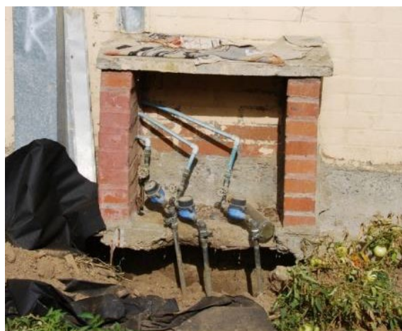
Figure 2-63. Raccordements aux divers réseaux endommagés par le séisme. 37
