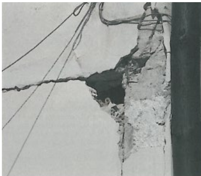
Figure 2-57. Dommages au nœud d'une colonne (Atene 1999); D4 36
