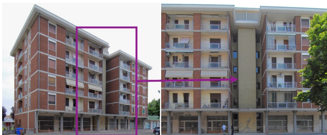
Figure IV-21. Tremblement de terre en Émilie-Romagne, Italie, en 2012. Bâtiment résidentiel de six étages dans une construction mixte en maçonnerie-béton armé avec un effet de «Soft-Story» (étage faible) modéré au rez-de-chaussée, malgré un noyau d'ascenseur en béton armé. Formation de fissures de cisaillement en X, voir figure IV-22.
