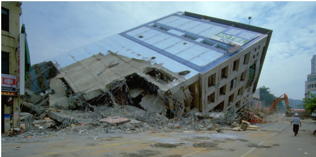
Figure IV-19. Tremblement de terre à Taïwan en 1999. Effondrement d'un hôtel dû à une défaillance au sous-sol. Les cadres et murs en béton armé massifs des étages supérieurs ont résisté à la chute, ce qui indique que ces étages avaient fait l'objet d'un dimensionnement sismique : degré de dommage 5
