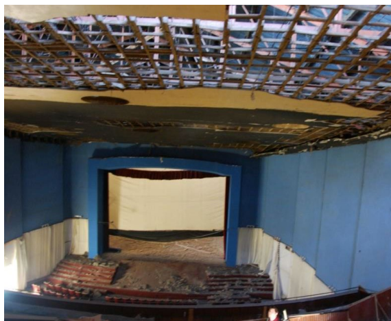
Figure 2-62. Des éléments de plâtre d'une épaisseur de plusieurs cm se détachent du faux-plafond et menacent l'espace situé en dessous. 37
