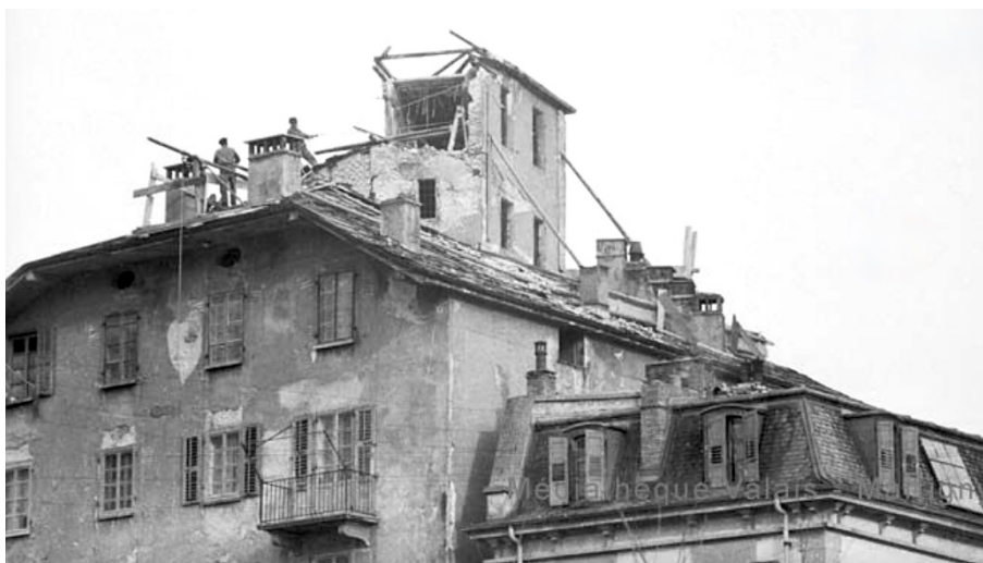
Figure IV-15. Tremblement de terre à Sierre dans le canton du Valais en 1946. Effondrement partiel des étages construits sur la toiture d'un bâtiment résidentiel à Sion (Raymond Schmid, Bourgeoisie de Sion, Médiathèque Valais, Martigny) : degré de dommage 4
