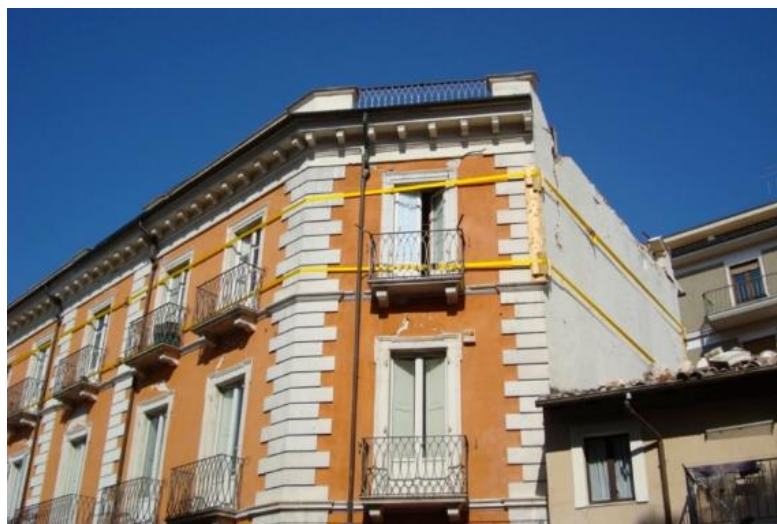
Figure 2-76. Exemple de ceinturage. 39
