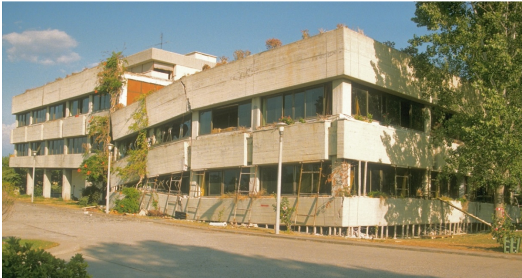
Figure IV-18. Tremblement de terre à Aegion, Grèce, en 1995. Effondrement d'un « étage mou » au rez-de-chaussée de la partie avant du bâtiment, le long du joint de dilatation qui relie cette partie à l'arrière du bâtiment, de conception similaire et seulement légèrement endommagé : degré de dommage 5
