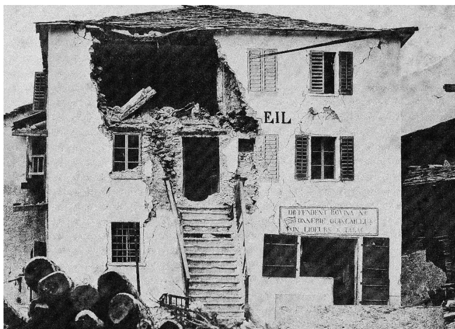
Figure IV-16. Tremblement de terre de Stalden-Viège en 1855. Effondrement partiel d'un mur de façade en maçonnerie de pierre naturelle dans les combles d'un bâtiment résidentiel à Stalden, dans le canton du Valais, dû à une défaillance sous sollicitation sismique hors-plan (source : CREALP, Sion) : degré de dommage 4
