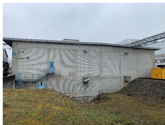
Figure 2-16. Remplissages en maçonnerie (un exemple que l'on rencontre régulièrement à l'étranger mais qu'occasionnellement pour les bâtiments résidentiels en Suisse) 14
