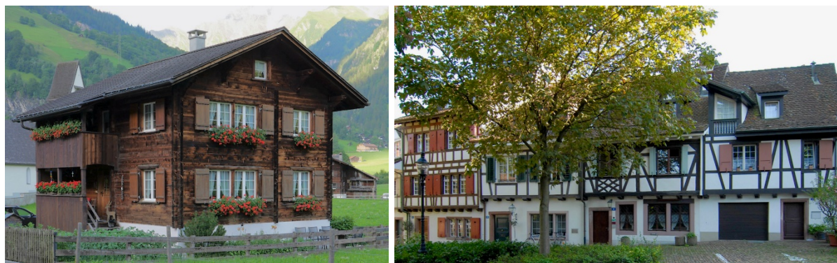
Figure II-12. Méthodes traditionnelles de construction en bois : construction en bois empilé dans le canton de Glaris (à gauche), bâtiments à colombages dans la vieille ville de Bâle (à droite)
