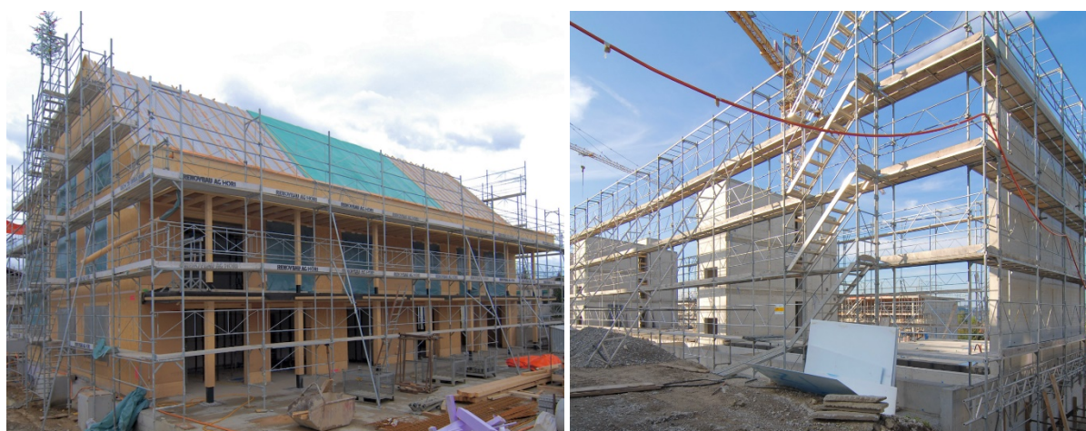
Figure II-13. Méthodes modernes de construction en bois dans le canton de Zurich pour un immeuble résidentiel : bâtiment avec une ossature en bois pur (à gauche), murs porteurs en béton armé construits avant l'assemblage des éléments en bois (à droite).
