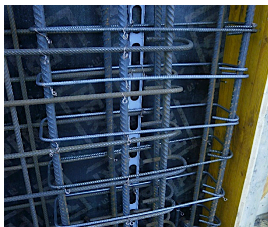
Figure 2-24. Détail d'armature d'un refend en b.a. 22
