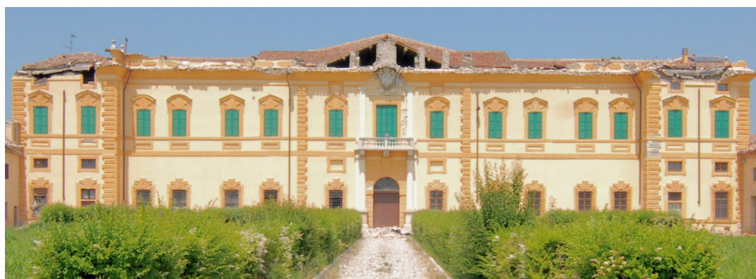
Figure IV-24. Tremblement de terre en Émilie-Romagne, Italie, en 2012. État du bâtiment de la figure IV-23 le 30 mai 2012 après la réplique du 29 mai 2012 d'une magnitude M_w = 5,9 . Le pignon longitudinal triangulaire, les parties supérieures du mur de façade, d'autres parties du toit et les cheminées se sont effondrés :
