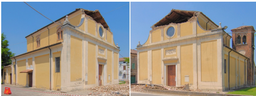
Figure IV-26. Tremblement de terre en Émilie-Romagne, Italie, en 2012. Deux vues de l'église paroissiale de Tramuschio de la figure IV-25 telle qu'elle se présentait le 30 mai 2012 après la réplique du 29 mai 2012 d'une magnitude M_w = 5,9 . Le pignon longitudinal triangulaire s'est effondré sur la rue : degré de dommage 4
