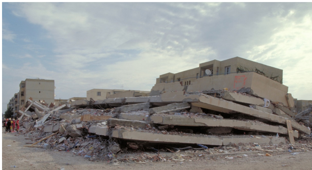
Figure IV-20. Tremblement de terre à Boumerdès, Algérie, en 2003. Effondrement en crêpe d'un bâtiment résidentiel en béton armé de cinq étages. La compression des planchers entre les dalles en béton armé est révélatrice d'un système de contreventement horizontal au moyen de cadres en béton insuffisamment armé et sans murs porteurs : degré de dommage 5 .
