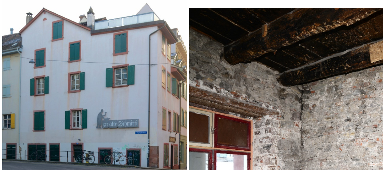
Figure II-2. Exemple d'un bâtiment médiéval en maçonnerie de pierre naturelle avec un plancher en bois à Bâle. La photo de droite montre l'encastrement sans ancrage mécanique des poutres des planchers dans le mur de façade.
