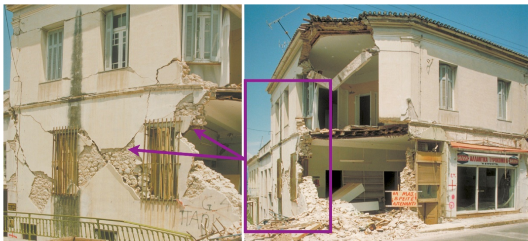
Figure IV-17. Tremblement de terre à Aegion, Grèce, en 1995. Effondrement des angles des murs de façade le long de fissures traversantes en forme de X au rez-de-chaussée d'un bâtiment en maçonnerie de pierre naturelle : degré de dommage 4
