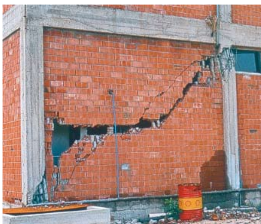
Abb. 2-38. Colonnes captives: cisaillement des poteaux de cadres engendré par le remplissage en maçonnerie. Cette typologie est plutôt rare en Suisse. 30
