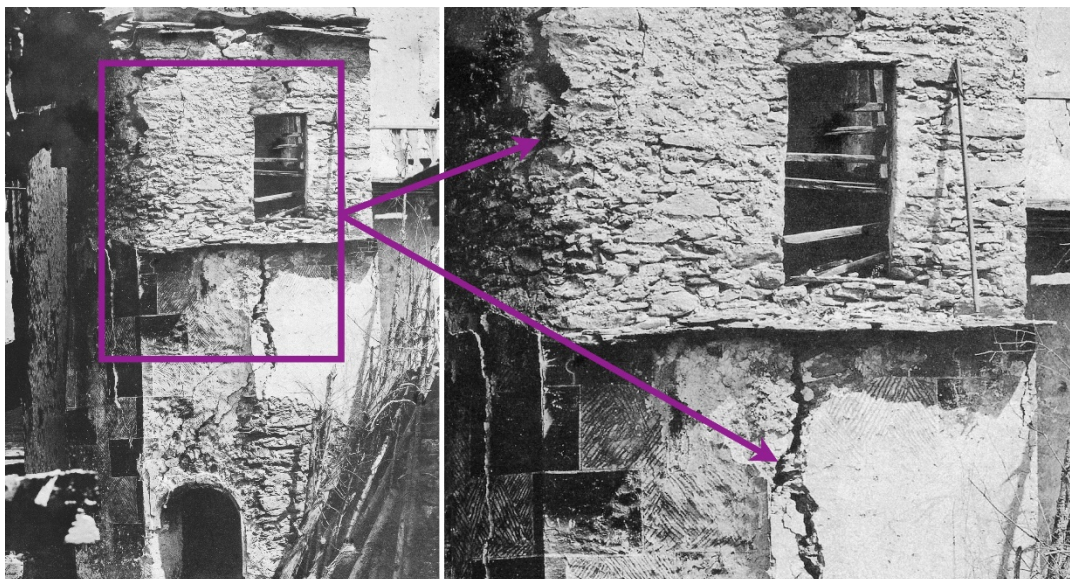
Figure IV-1. Tremblement de terre à Stalden-Viège en 1855. Fissure verticale longue et étendue à travers le mur de façade d'un bâtiment en maçonnerie de pierre naturelle à Stalden dans le canton du Valais (source : CREALP, Sion) : degré de dommage 3
