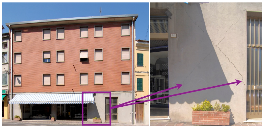
Fig. IV-9. Tremblement de terre en Émilie-Romagne, Italie, en 2012. Longues fissures en forme de X dans le plâtre d'un mur en maçonnerie au rez-de-chaussée d'un bâtiment résidentiel et commercial de quatre étages : degré de dommage 2
