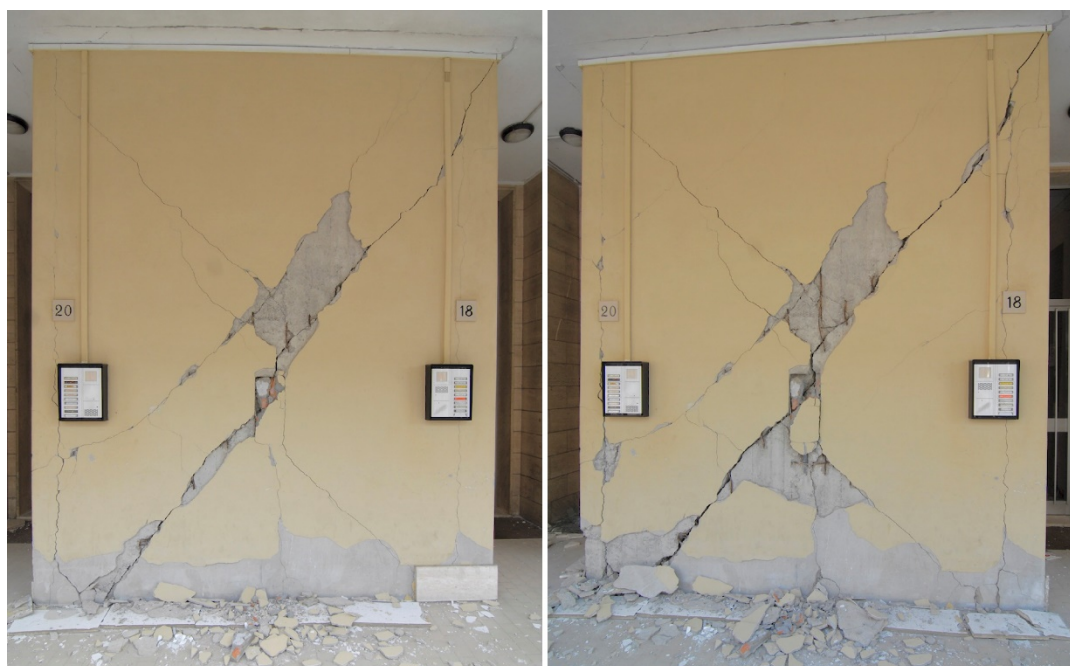
Figure IV-22. Tremblement de terre en Émilie-Romagne, Italie, en 2012. Évolution des dommages au noyau de l'ascenseur en béton armé au rez-de-chaussée de l'immeuble d'habitation, illustré à la figure IV-21 :
