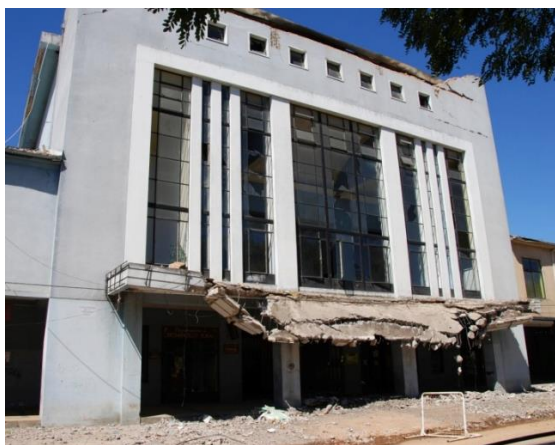
Figure 2-60. Mise en danger de la zone environnante par un parapet non retenu à l'arrière (une partie s'est déjà effondrée sur l'avant-toit). Le danger serait écarté en enlevant le parapet. 37
