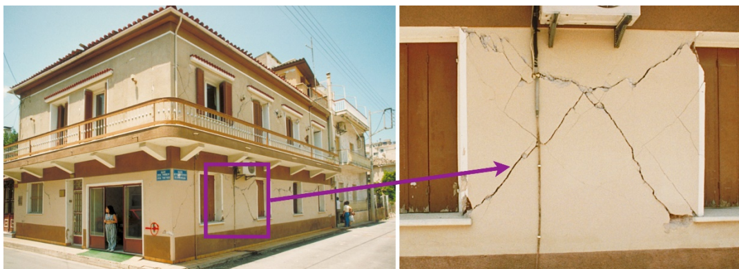
Figure IV-12. Tremblement de terre à Aegion, Grèce, en 1995. Nombreuses fissures traversantes en forme de X typiques en cas de sollicitations sismiques, au rez-de-chaussée et au 1 er étage d'un bâtiment résidentiel : degré de dommage 3
