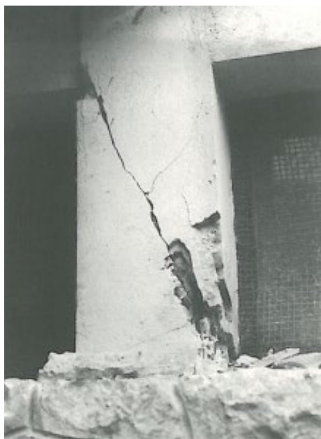
Figure 2-55. Colonne courte (Castelluccio Inferiore, PZ, 1998); D3-4 36
