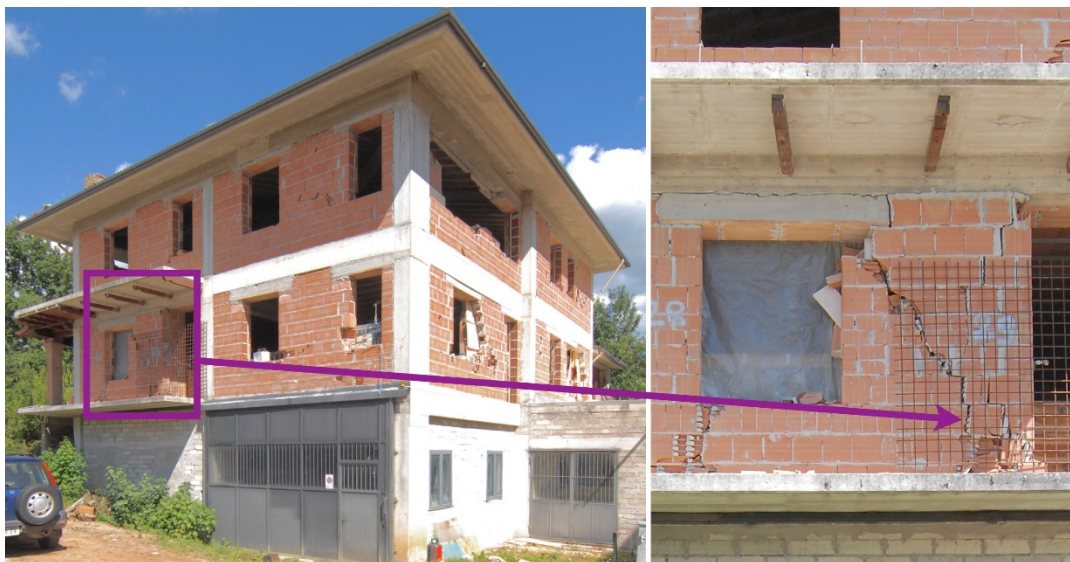
Figure IV-14. Tremblement de terre à Amatrice, Italie, en 2016. Fissures longues et étendues sur les quatre murs de la façade d'un bâtiment en maçonnerie encore en construction : degré de dommage 3
