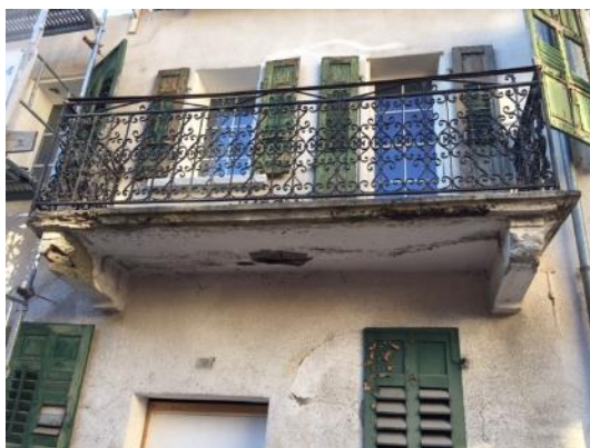
Abb. 2-36. Exemples de bâtiments présentant des dommages liés à un manque d'entretien 30
