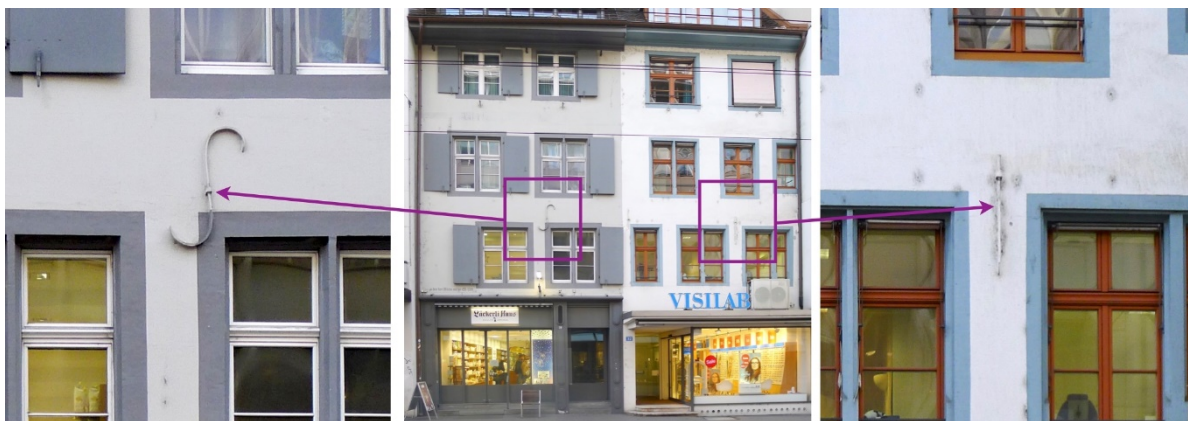
Figure II-15. Ancrages dans les façades longitudinales de deux bâtiments en maçonnerie de la vieille ville de Bâle
