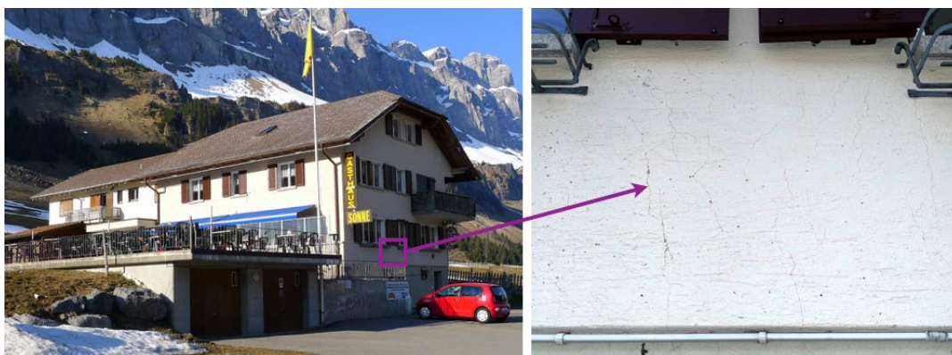
Figure IV-2. Tremblement de terre à Linthal dans le canton de Glaris en 2017. Gasthaus Sonne à l'épicentre, avec des fissures capillaires diagonales dans le plâtre du mur pignon : degré de dommage 1
