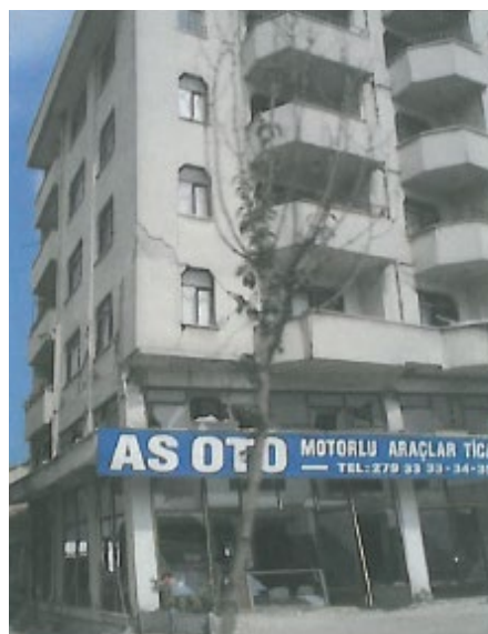
Figure 2-58. Formation de rotules plastiques aux extrémités des colonnes (Turchia, 1999); D4-5 36
