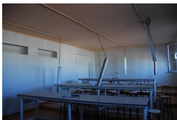
Figure 2-65. Mise en danger des utilisateurs par des unités d'éclairage mal fixées. La suppression de celles-ci ou de nouvelles fixations renforcées supprimeraient le danger. 37
