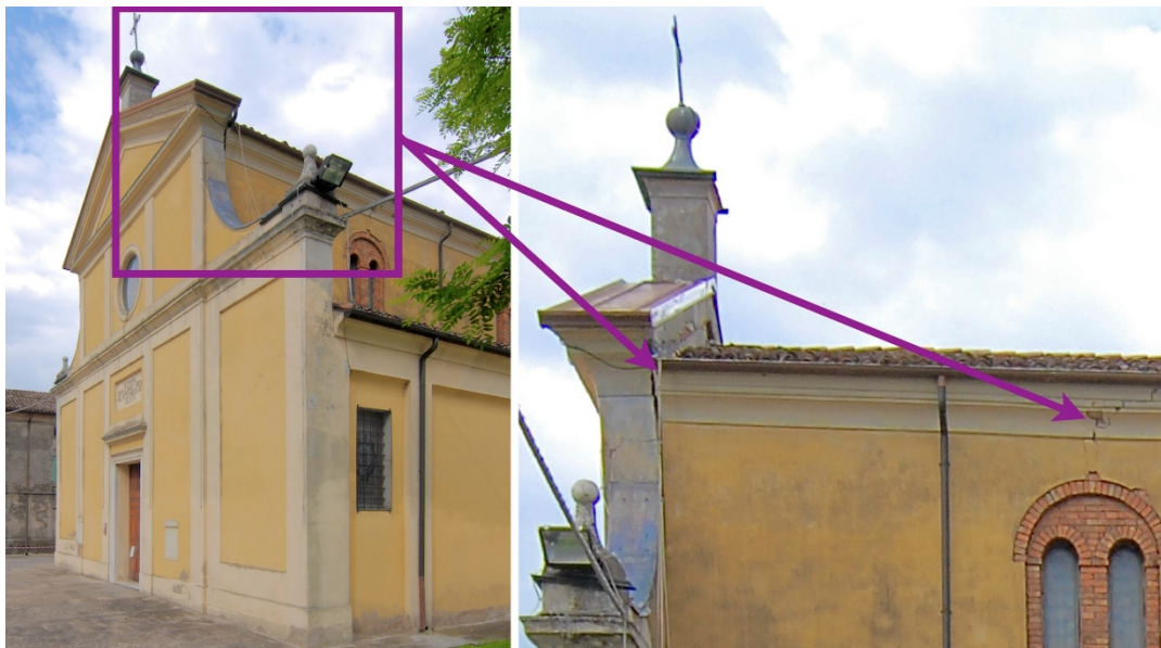
Figure IV-25. Tremblement de terre en Émilie-Romagne, Italie, en 2012. L'église paroissiale de Tramuschio dans la Province de Modène au 28 mai 2012 après la secousse principale du 20 mai 2012 d'une magnitude M_w = 5,9 . Fissures dans les murs avec de petites écailles de plâtre et fissure traversante dans la partie supérieure, entre le mur longitudinal et le mur pignon : degré de dommage 2
