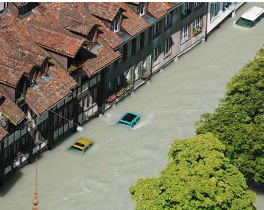
Les dangers naturels apparaissent comme les plus à même d'entraîner une intervention de l'organe de conduite de la région Berne plus. Photo: crues de l'Aar en 2005.
