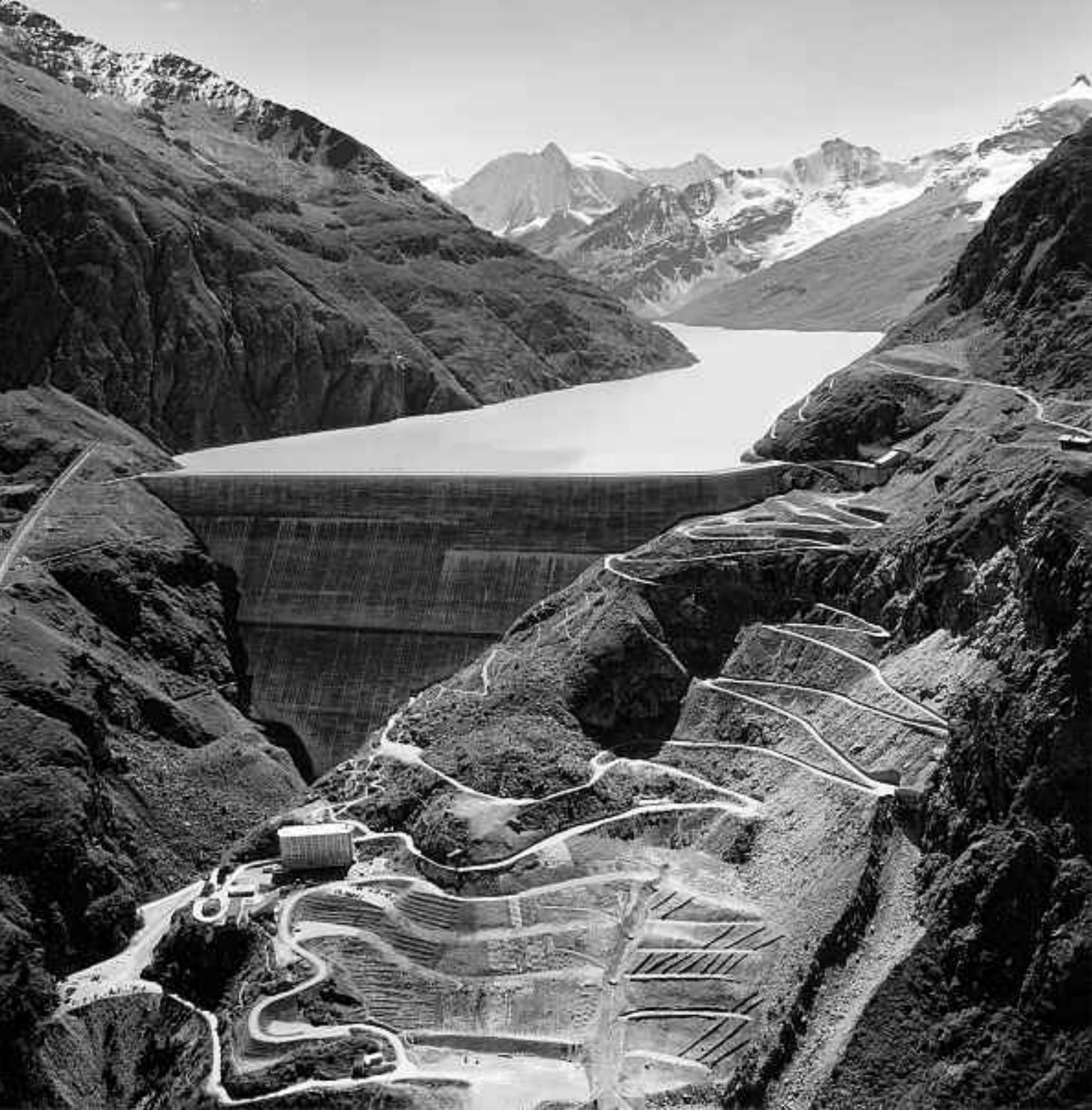
4 Le Barrage Grande Dixence (1953, ingénieur Alfred Stucky). Photo © Photographe H. Preisig. Extrait publication Architecture du XXe en Valais .
