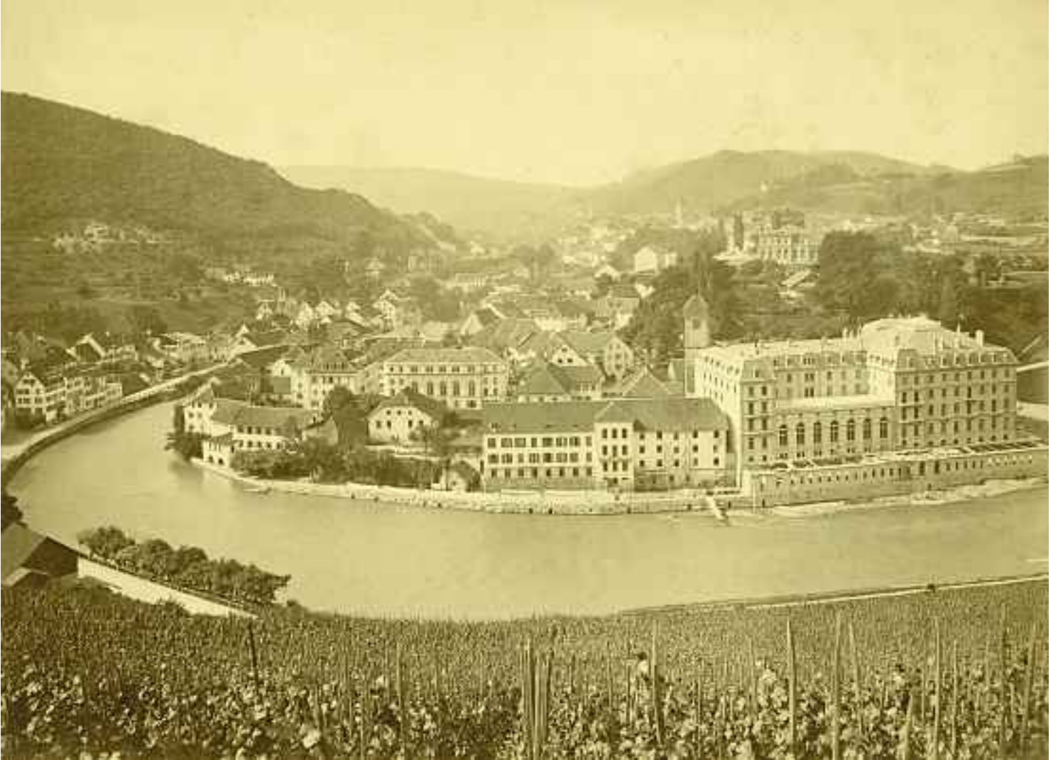
1 Der Blick auf das Bäderquartier bzw. auf die Grossen Bäder im Limmatknie um 1875/76. Ganz dominant rechts im Bild das fast fertiggestellte Grand Hotel und die dahinterliegende Dreikönigskapelle, welche erst 1882 abgerissen wurde. Foto © Kantonale Denkmalpflege Aargau, Bildarchiv.
