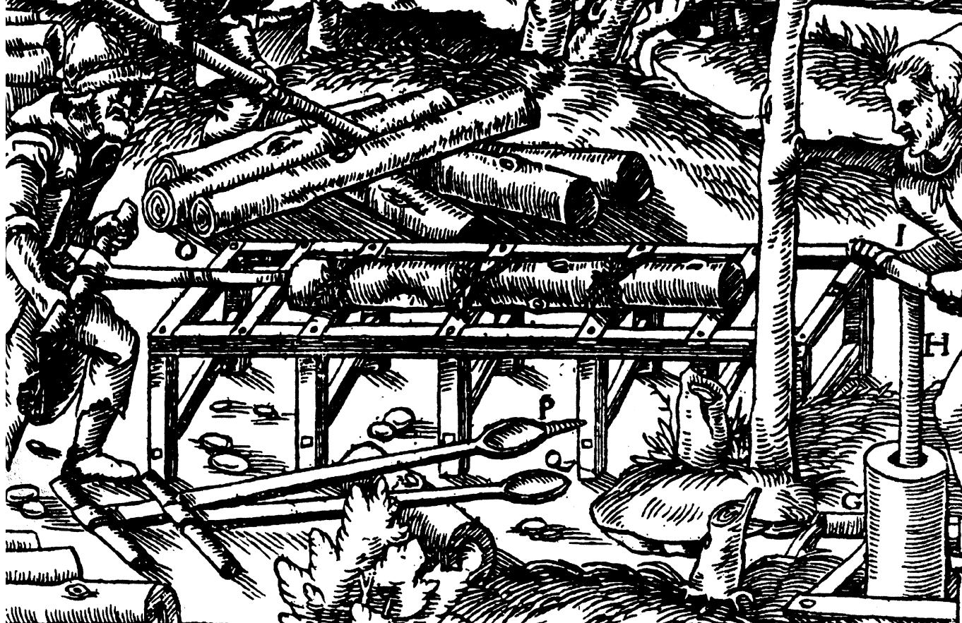
3 Das Teuchelbohren. Die Bohrungen ergaben Leitungsquerschnitte von 6 bis 10 cm. Holzschnitt aus Georg Agricola 1556 (Ausschnitt). Abbildung © Archäologischer Dienst des Kantons Bern.
