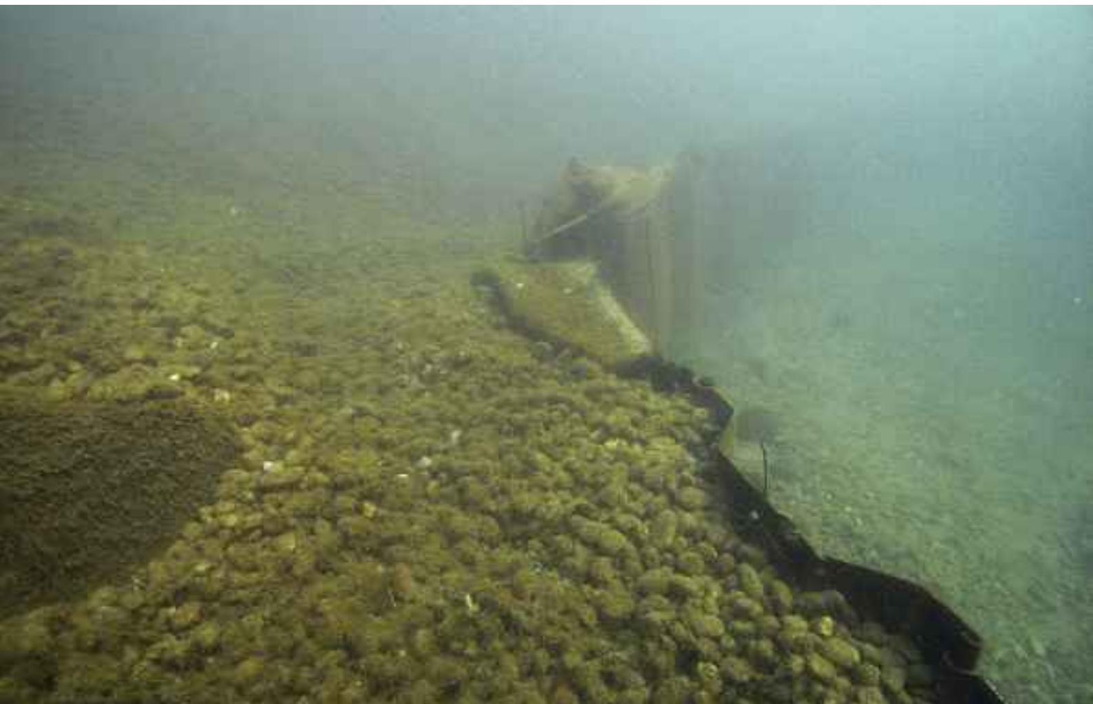
3 UNESCO-Pfahlbaufundstelle Meilen-Rorensaal: Vertikaler Profilschutz mit Metallwand und anschliessender Kiesaufschüttung. Foto © Unterwasserarchäologie Zürich, Amt für Städtebau.
