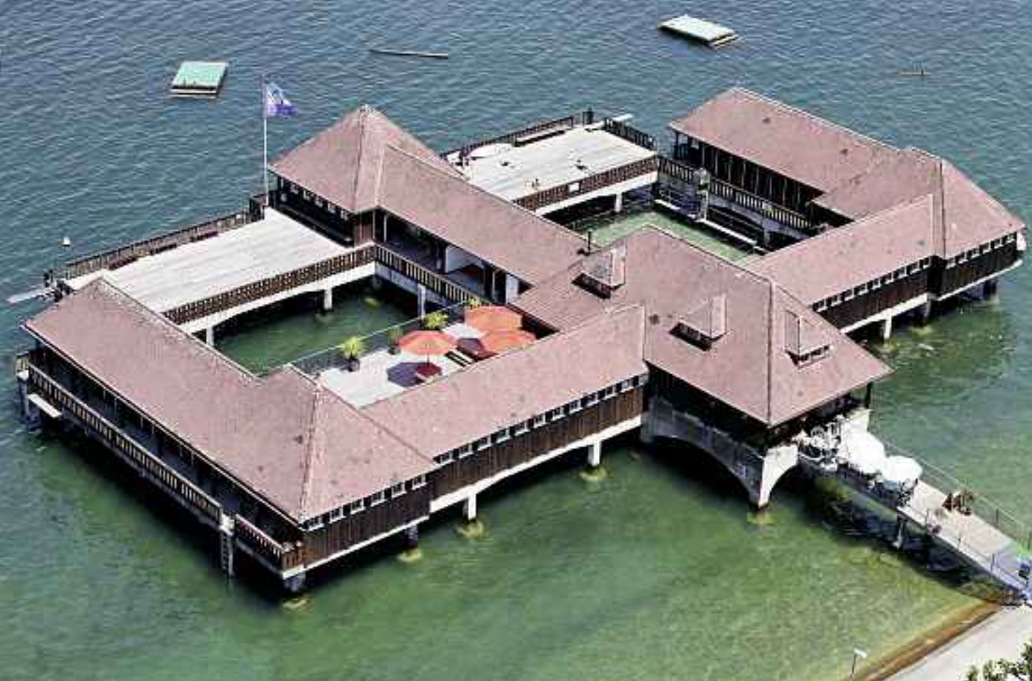
3 Luftaufnahme der 1923 erbauten «Badhütte» Rorschach. In den beiden Becken befanden sich ursprünglich verstellbare Roste für die Nichtschwimmer. Foto © Dukas Presseagentur GmbH / Alamy Stock Foto. Lizenz beim Autor.
