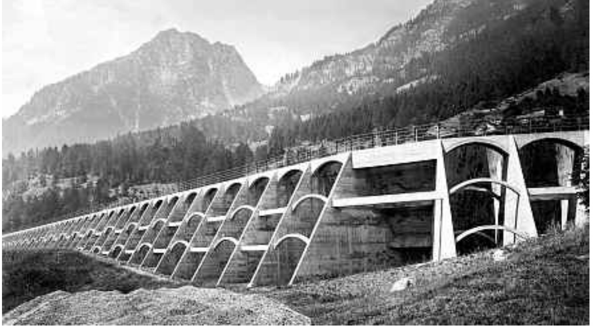
5 Le réservoir des Marécottes. Photo © Bureau Sollertia, Archives A. Sarrasin. Extrait publication Architecture du XX e siècle en Valais .
