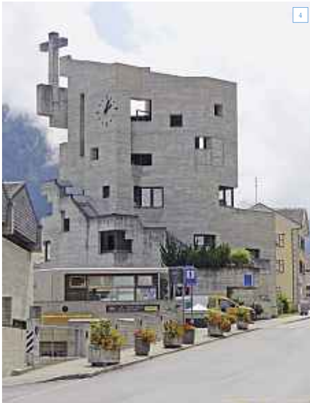
4 L'église paroissiale St-Nicolas à Hérémence (VS), une sculpture en béton, a été construite entre 1967 et 1971 par Walter Förderer. Photo: © Hans Schüpbach, Section PBC, OFPP.
