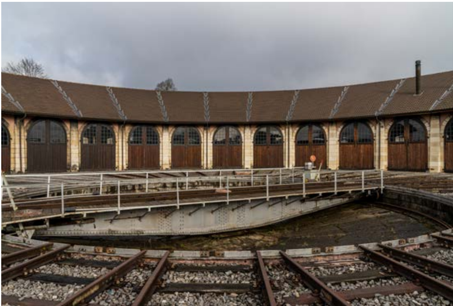
Rotonde pour locomotives, remises, Delémont
