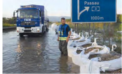
Abb. 63: Improvisiertes Behältersystem mit Industriesäcken (THW)
