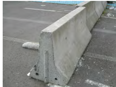
Abb. 65: Elemente mobiler Betonschutzwände (Wikipedia)
