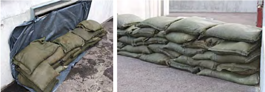
Abb. 50: Beispiele einfacher Sandsackmauern (BABS)
