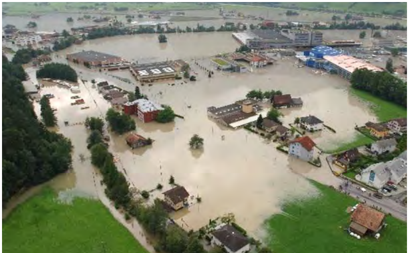
Abb. 3: Statische Überschwemmung in Schattdorf UR (Faktenblatt Hochwasser und Murgänge, BAFU)
