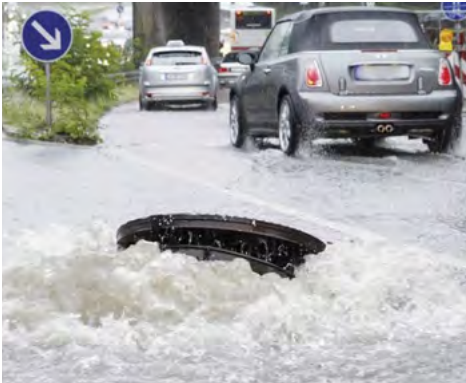
Abb. 14: Rückstau über die Kanalisation (Bruno Gerber, Tiefbauamt Kanton Bern)
