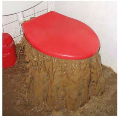
Abb. 14: Rückstau über die Kanalisation (Bruno Gerber, Tiefbauamt Kanton Bern)
