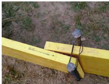
Sicherung der Armierungseisen mit Drilldraht
