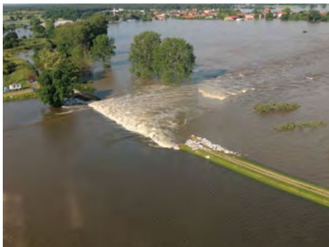
Abb. 68: Deichbruch (Robert Jüpner, Technische Universität Kaiserslautern)
