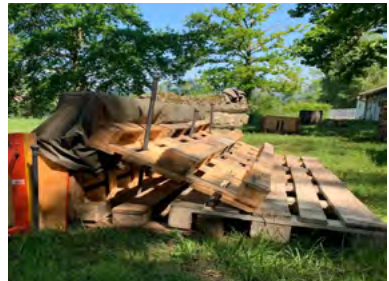
Abb. 60: Palettenwehr mit drei Paletten und Palettenwehr mit vier Paletten (BABS)
