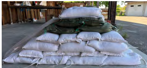
Abb. 47: Aufbau eines normalen Damms (BABS)
