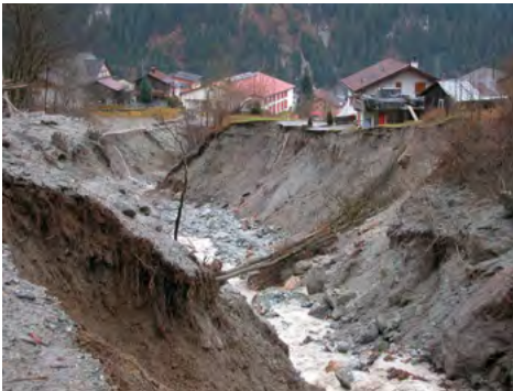
Abb. 9: Seiten- und Tiefenerosion in Rueun GR (PLANAT)
