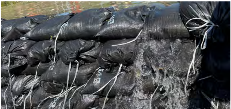
Abb. 41: Überströmter Sandsackdamm (BABS)
