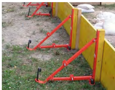
Sicherung mit verstellbaren Abschalböcken aus dem Bausektor
