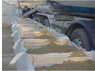
Abb. 64: Abfüllen von versteiften Big Bags mit einem Fahrmischer (INN-PACK)
