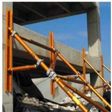
Abb.106: Strebstützen mit Systemstützen aus dem Rettungssektor
