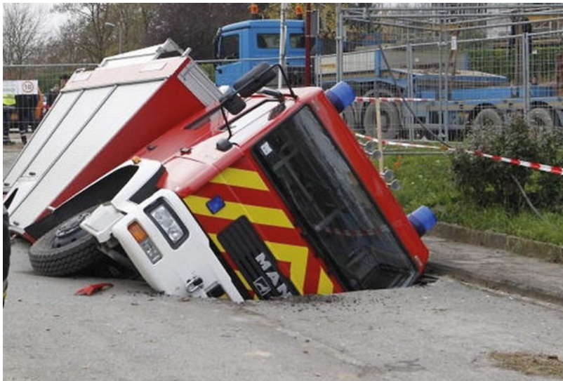
Abb. 19: Fahrzeugeinsturz wegen unterspülter Strasse (Luxemburger Wort)
