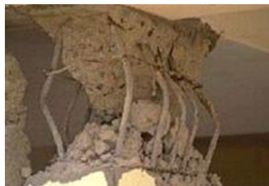
Abb.5: Freiliegende Armierungseisen
