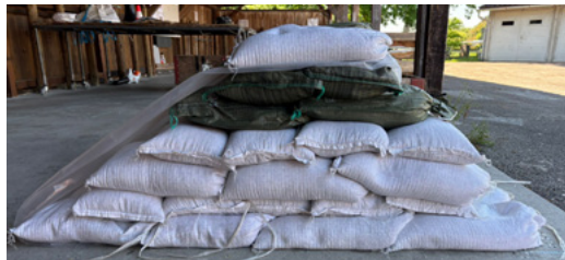
Abb. 47: Aufbau eines normalen Damms (BABS)
