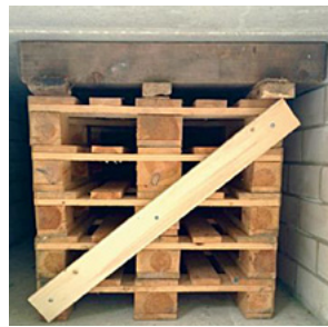
Abb. 71: Beispiel eines korrekt aufgebauten Palettenstapels (Blockhaus, THW)
