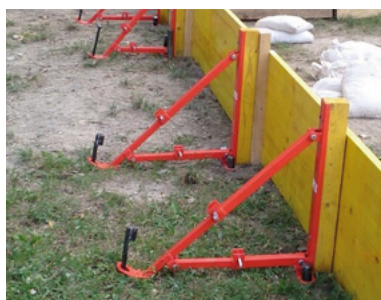
Sicherung mit verstellbaren Abschalböcken aus dem Bausektor
