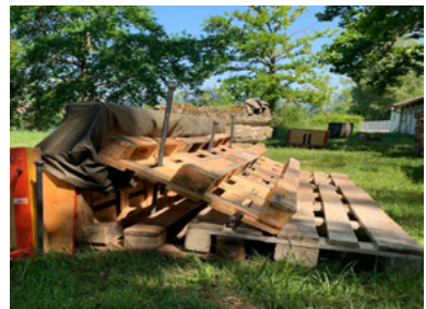
Abb. 60: Palettenwehr mit drei Paletten und Palettenwehr mit vier Paletten (BABS)
