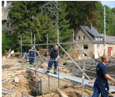
Abb. 93: Trümmersteg mit EGS (THW)
