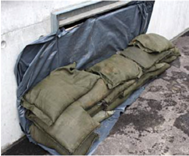
Abb. 50: Beispiele einfacher Sandsackmauern (BABS)
