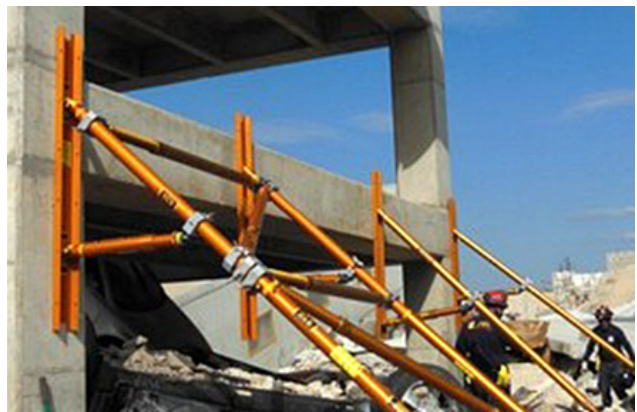
Abb. 27: Abstützungen mit multifunktionellen Rettungsstützen (Paratech)
