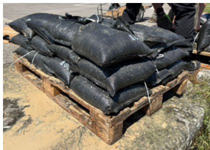
Abb. 52: Sandsäcke auf Europaletten bereitstellen (THW & BABS)
