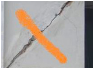
Abb. 17: Überwachung mit Farbstrich (Regina Wenk)
