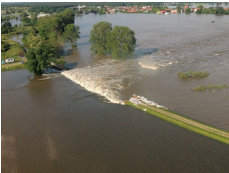
Abb. 68: Deichbruch (Robert Jüpner, Technische Universität Kaiserslautern)
