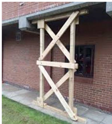
Abb. 54: Beispiel eines senkrechten Flächentragwerks aus Holz (FEMA)
