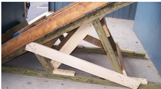
Abb. 92: Schräges Raumfachwerk aus Holz (rechtwinklige Methode) (FEMA)
