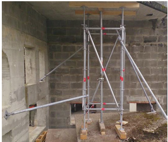
Abb. 60: Senkrechte Raumfachwerke aus Systemstützen und aus Gerüstbaumaterial
