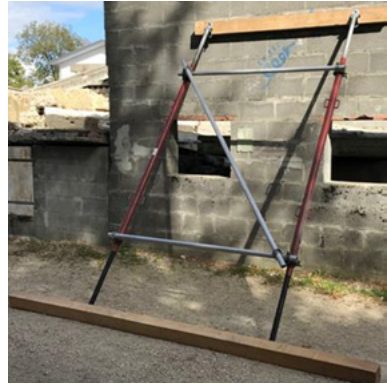
Abb.105: Einfache Strebstützen mit Systemstützen und mit Richtstützen (ohne Streichbalken) aus dem Bausektor
