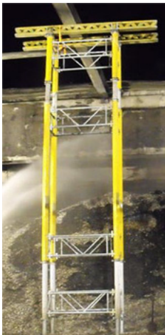
Abb. 60: Senkrechte Raumfachwerke aus Systemstützen und aus Gerüstbaumaterial
