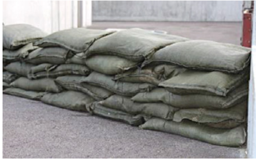
Abb. 50: Beispiele einfacher Sandsackmauern (BABS)
