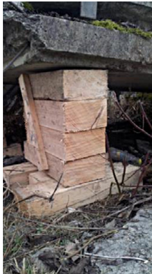
Abb. 74: Beispiele von einfachen Kantholzstapeln (Regina Wenk)
