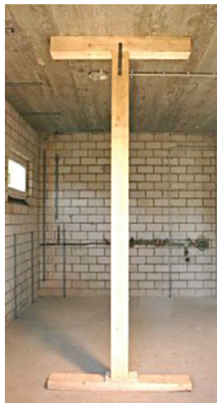
Abb. 45: Senkrechte Holzstütze (Blockhaus, THW)
