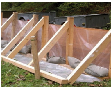
Zusätzliche Abstützung mit Kantholz
