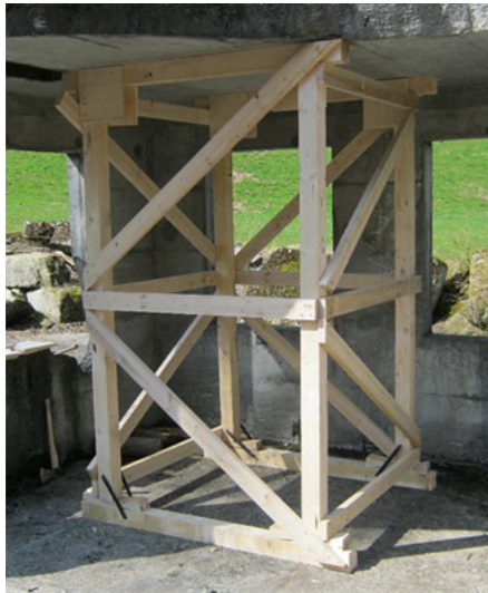
Abb. 59: Beispiel eines senkrechten Raumfachwerks aus Holz
