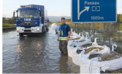
Abb. 63: Improvisiertes Behältersystem mit Industriesäcken (THW)
