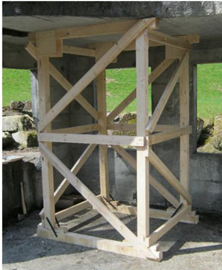
Abb. 59: Beispiel eines senkrechten Raumfachwerks aus Holz
