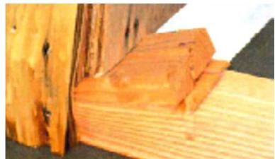
Abb. 16: In die Schwelle- oder den Unterzug eingedrückte Stützen zeigen eine Überlastung des Abstützsystems an (FEMA)
