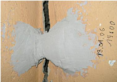
Abb.18: Gipsiegel über einem Riss
