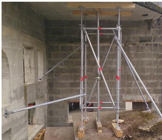
Abb. 60: Senkrechte Raumfachwerke aus Systemstützen und aus Gerüstbaumaterial
