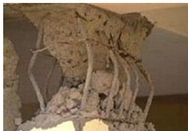
Abb.5: Freiliegende Armierungseisen
