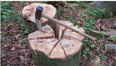
Abb. 35: Holz spalten mit Spaltkeil
