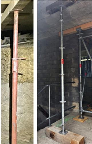
Abb. 46: Einzelstützen aus dem Bausektor (Blockhaus, THW)
