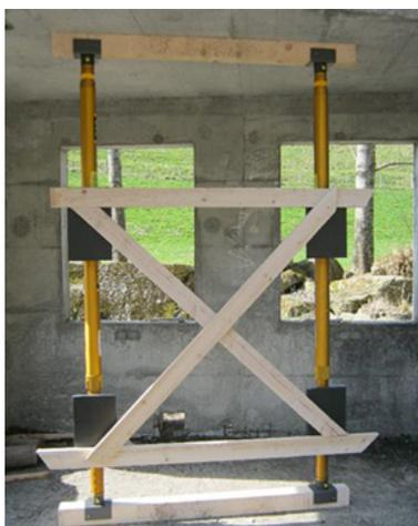
**Abb. 56: Senkrecht Flächenfachwerk mit Systemstützen aus dem Rettungssektor**
