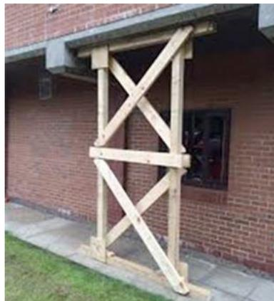
Abb. 54: Beispiel eines senkrechten Flächenfachwerks aus Holz (FEMA)
