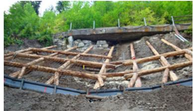
Abb. 71: Ausfachtung mit Distanzhölzern (Ammann Ingenieurbüro AG)
