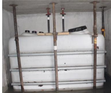
Abb. 83: Sicherung eines Heizöltanks (Gebäudeversicherung Bern GVB)
