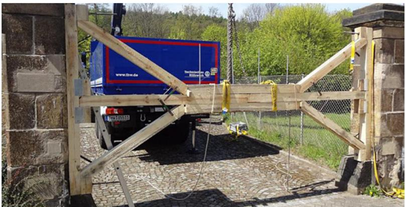
Abb.79: Beispiel eines Sprengwerks (THW)
