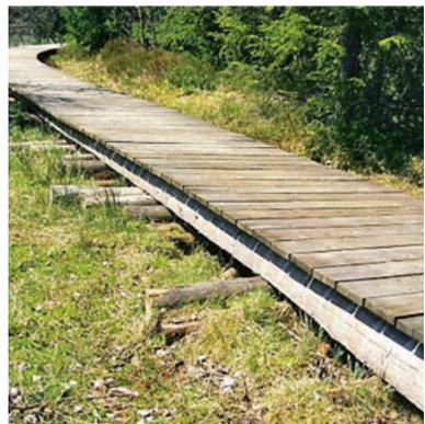
Abb. 83: Konstruktion mit Querbalken (ASTRA)
