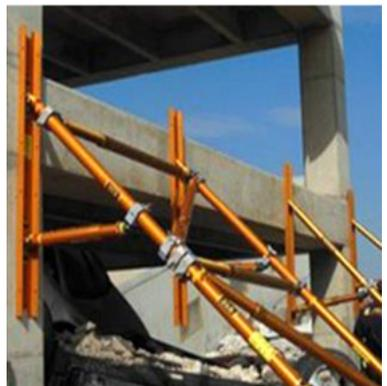
Abb.106: Strebstützen mit Systemstützen aus dem Rettungssektor
