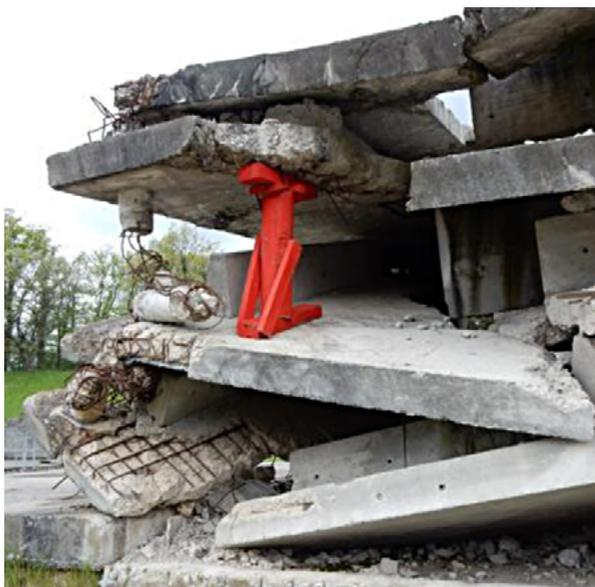
Abb. 49: Sehr gefährliche und unbrauchbare Abstützung einer auskragenden Deckenplatte
