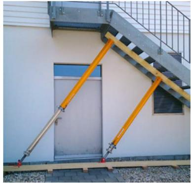
**Abb. 90: Schräges Flächenfachwerk mit Systemstützen aus dem Bausektor (rechtwinklige Methode)**
