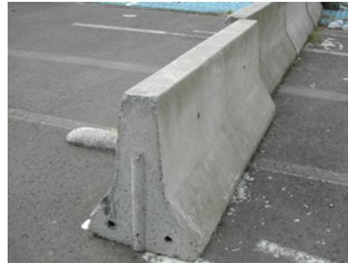
Abb. 65: Elemente mobiler Betonschutzwände (Wikipedia)
