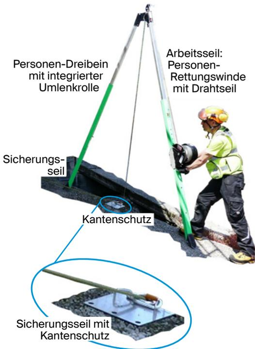
Abb.70: Rettung mit einem Personendreibein und einer Personenwinde (Bild ohne Absturzsicherung)
