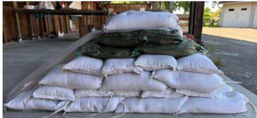
Abb. 47: Aufbau eines Regeldamms (BABS)
