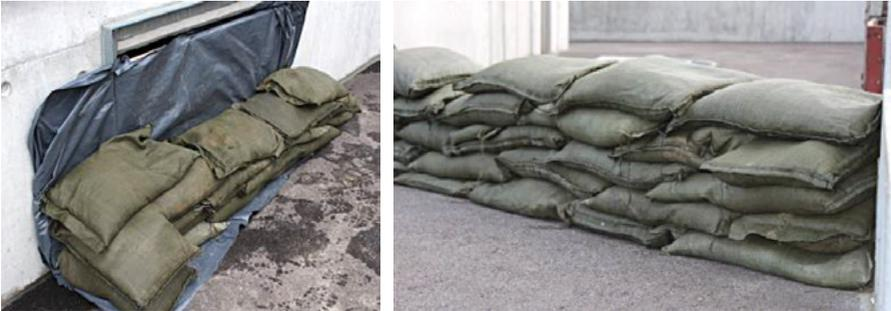
Abb. 50: Beispiele einfacher Sandsackmauern (BABS)
