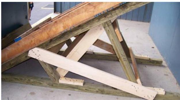
**Abb. 92: Schräges Raumfachwerk aus Holz (rechtwinklige Methode) (FEMA)**
