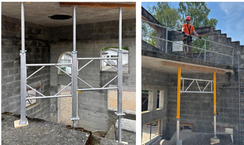
**Abb. 55: Senkrecht Flächenfachwerk mit Systemstützen aus dem Bausektor (BABS)**
