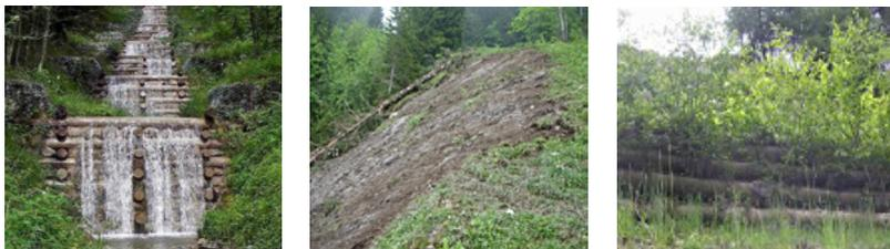
Abb. 38: Beispiele für Nasslagerung, Erdeindeckung und Bepflanzung
