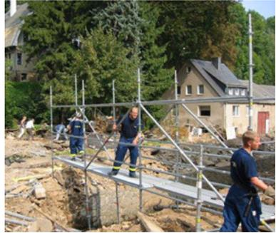
Abb. 93: Trümmersteg mit EGS (THW)
