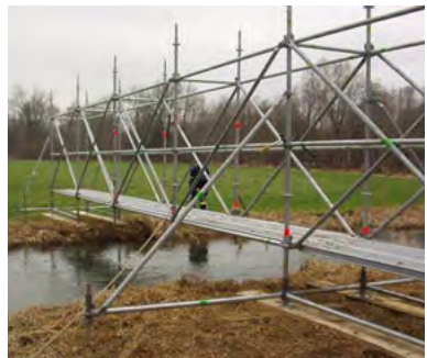
Abb. 95: Steg in der Ausführung von 9 Metern, freitragend (THW)
