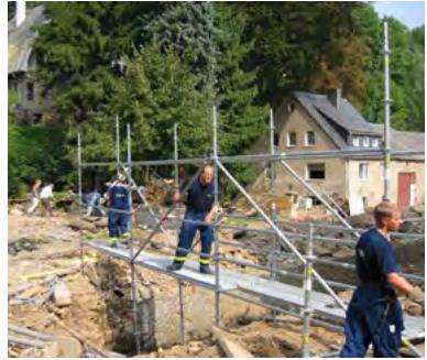
Abb. 93: Trümmersteg mit EGS (THW)
