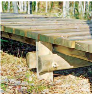
Abb. 82: Steg auf Pfeilern (ASTRA)
