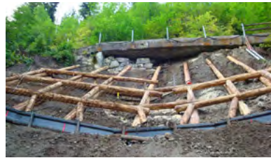
Abb. 71: Ausfachtung mit Distanzhölzern (Ammann Ingenieurbüro AG)
