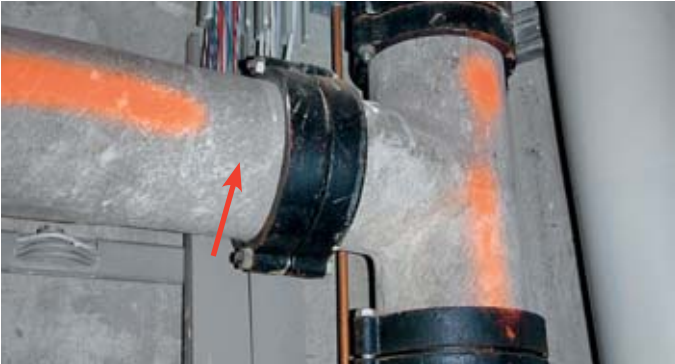
Asbestzementrohr
