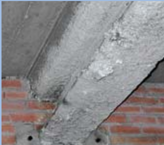
Spritzasbestisolierung
