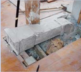
Lüftungskanal aus Asbestzement
