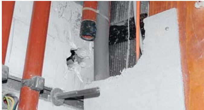
Brandschutzplatte in Steigzone
