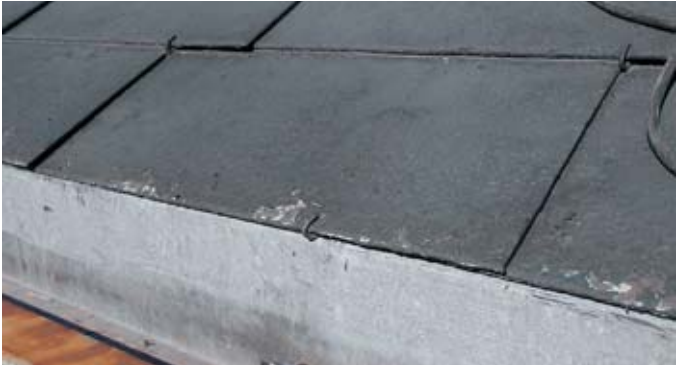
Asbesthaltige Schieferplatten
