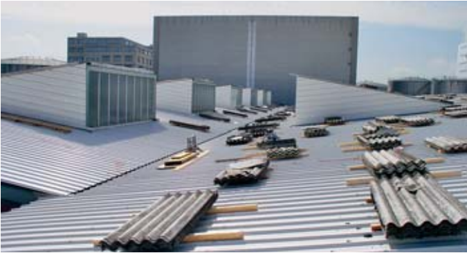
Asbesthaltige Wellplatten
