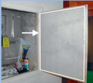
Asbesthaltige Brandschutzplatte
