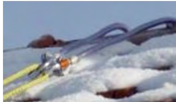
Verankerung am Dachfirst
