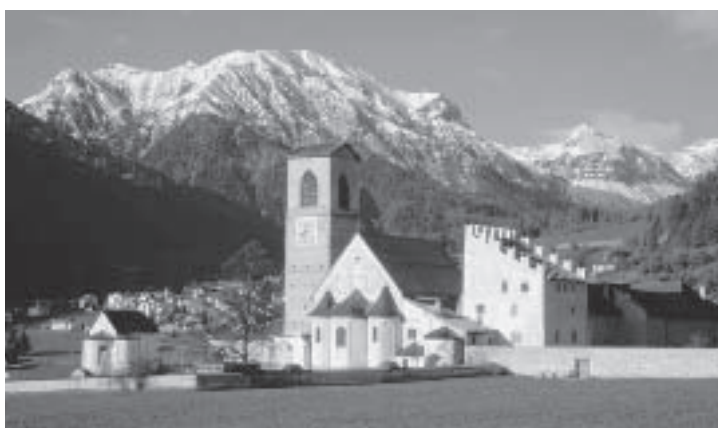
Fig. 1: Le couvent Saint-Jean-des-Soeurs à Müstair pourrait peut-être bénéficier d'une «protection renforcée» selon le Deuxième Protocole.
