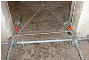
Abb. 19: Querriegel mit Gerüstrohren in einer Türöffnung (THW)
