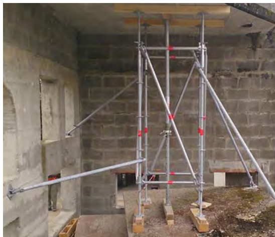
Abb. 60: Senkrechte Raumfachwerke aus Systemstützen und aus Gerüstbaumaterial
