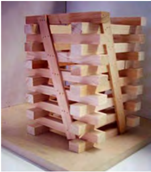
Abb. 66: Sichern von Kreuzholzstapel
