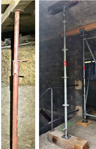
Abb. 46: Einzelstützen aus dem Bausektor (Blockhaus, THW)
