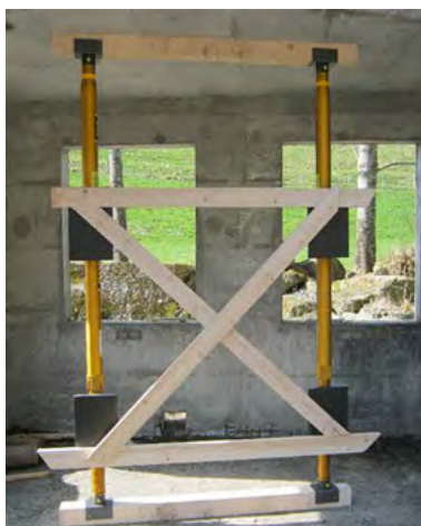
Abb. 56: Senkrechtcs Flächenfachwerk mit Systemstützen aus dem Rettungssektor
