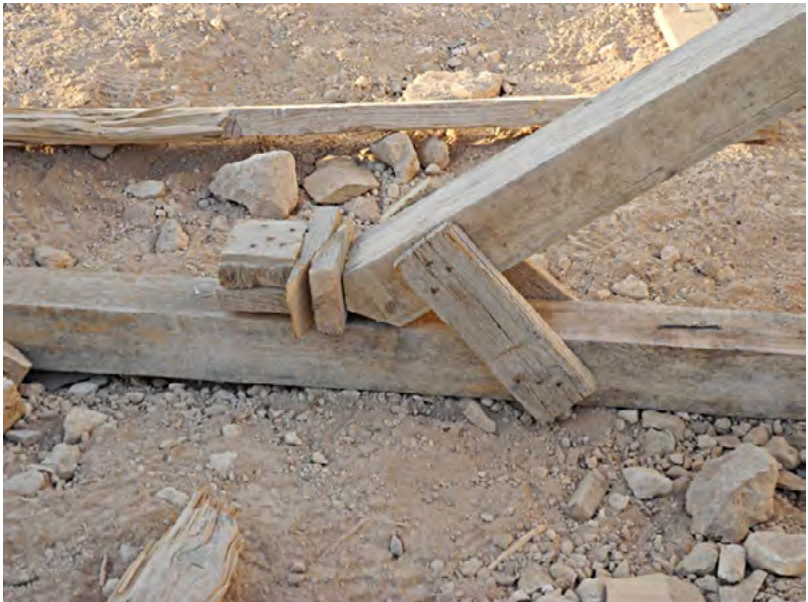
Abb.110: Ungenügend gesicherte Stütze auf der Treiblade (Regina Wenk)
