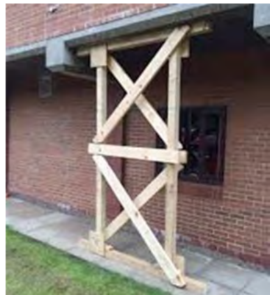
Abb. 54: Beispiel eines senkrechten Flächenfachwerks aus Holz (FEMA)
