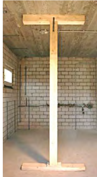
Abb.45: Senkrechte Holzstütze (Blockhaus, THW)
