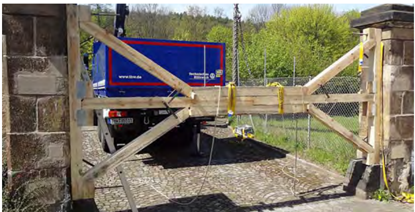
Abb.79: Beispiel eines Sprengwerks (THW)
