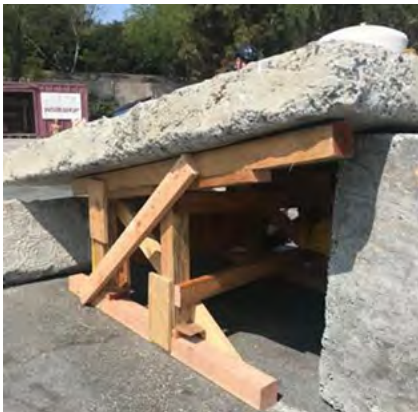
Abb.95: Schräges Raumfachwerk aus Holz (senkrechte Methode) (FEMA)
