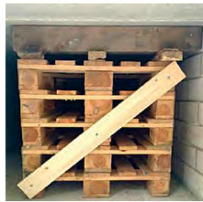
Abb. 71: Beispiel eines korrekt aufgebauten Palettenstapels (Blockhaus, THW)
