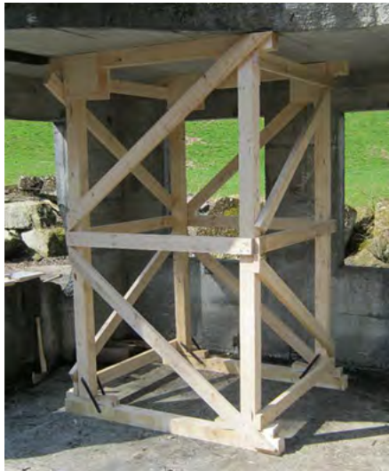
Abb. 59: Beispiel eines senkrechten Raumfachwerks aus Holz
