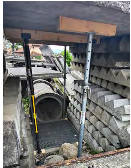
Abb. 47: Einzelstütze aus dem Rettungssektor (Paratech)
