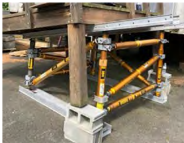
Abb.96: Schräges Raumfachwerk mit Systemstützen aus dem Rettungssektor (senkrechte Methode) (Paratech)
