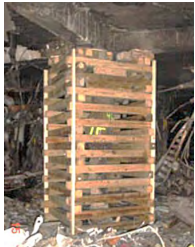
Abb.69: Abstützung mit Kreuzholzstapel im Pentagon nach dem Terroranschlag (FEMA)
