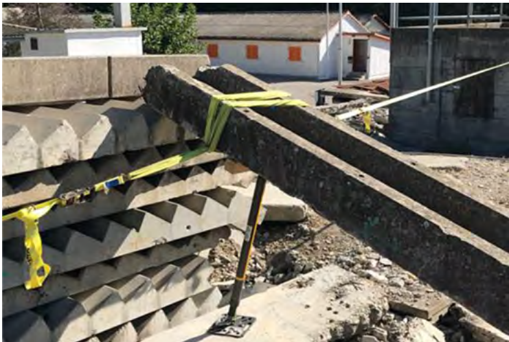
Abb. 87: Schnellsicherung eines schrägen Bauteils mit einer Rettungsstütze und seitlicher Abspannung mit Zurrgurten gegen Verschiebung
