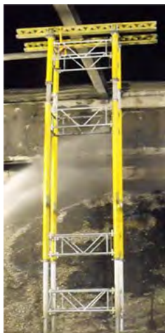
Abb. 60: Senkrechte Raumfachwerke aus Systemstützen und aus Gerüstbaumaterial
