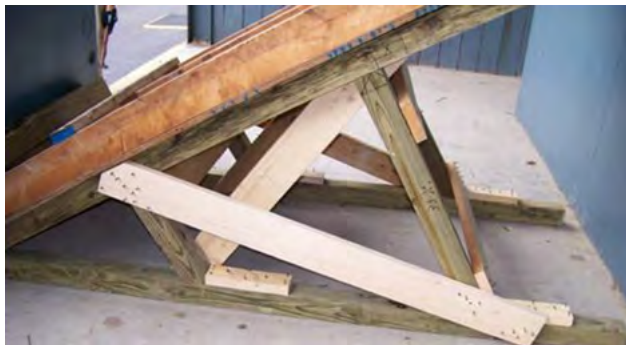
Abb. 92: Schräges Raumfachwerk aus Holz (rechtwinklige Methode) (FEMA)
