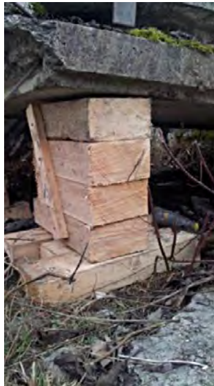
Abb. 74: Beispiele von einfachen Kantholzstapeln (Regina Wenk)
