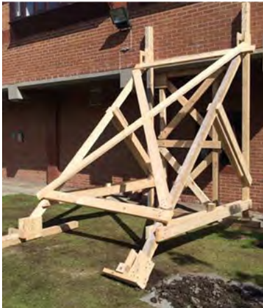
Abb.22: Wandabstützung aus Holz (FEMA)
