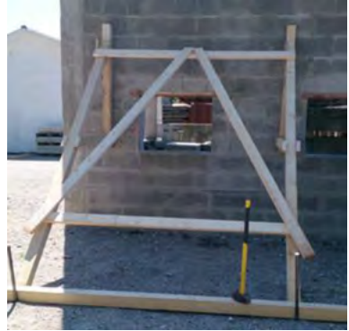
Abb.104: Beispiel Strebstütze aus Holz
