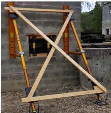
Abb.106: Strebstützen mit Systemstützen aus dem Rettungssektor
