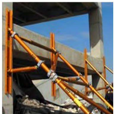
Abb.106: Strebstützen mit Systemstützen aus dem Rettungssektor
