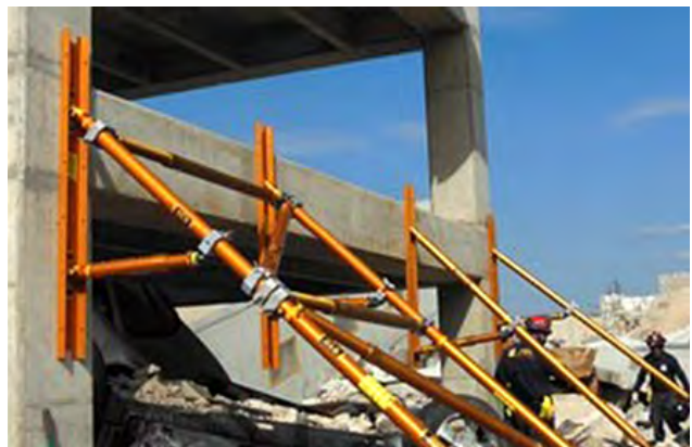
Abb.27: Abstützungen mit multifunktionellen Rettungsstützen (Paratech)
