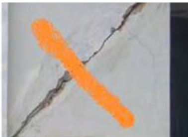
Abb.17: Überwachung mit Farbstrich (Regina Wenk)
