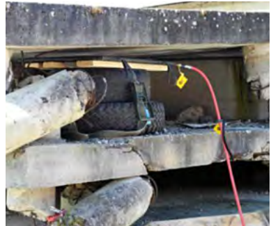
Abb. 115: Beispiel alternative Abstützung: Mit Steinen gefüllte Pneus, gegen seitliche Verschiebung mit Zurring gesichert und mit Hebekissen kraftschlüssig eingespannt (Rettungskette Schweiz)
