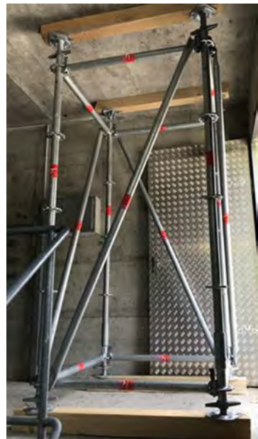
Abb.26: Raumfachwerk mit dem EGS
