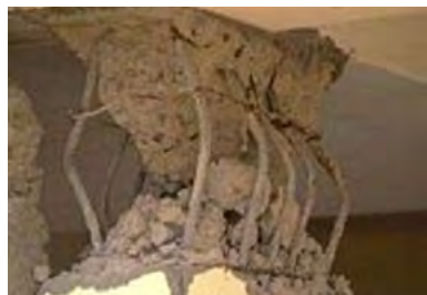
Abb.5: Freiliegende Armierungseisen
