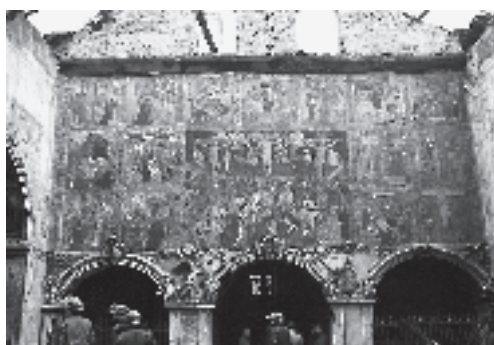
Fig. 7-9: Grazie all'intervento rapido dei pompieri è stata evitata la distruzione totale del patrimonio culturale della chiesa (© Consorzio PBC, Bellin- zona)
