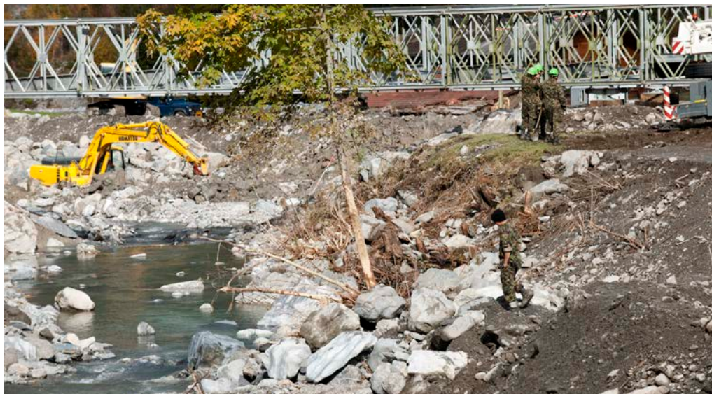
Abbildung 5: Erstellen einer Notbrücke im betroffenen Gebiet
