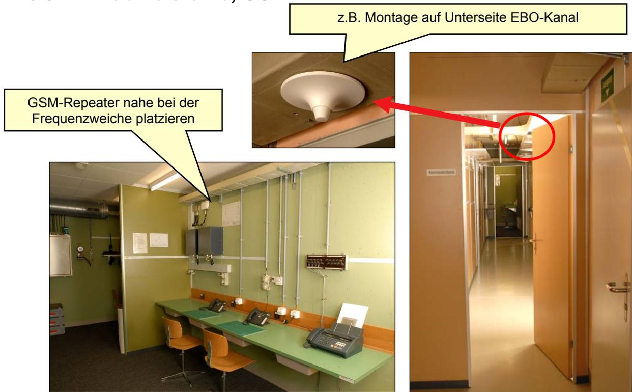
Abbildung 25 GSM-Repeater und - Innenantenne(n)
