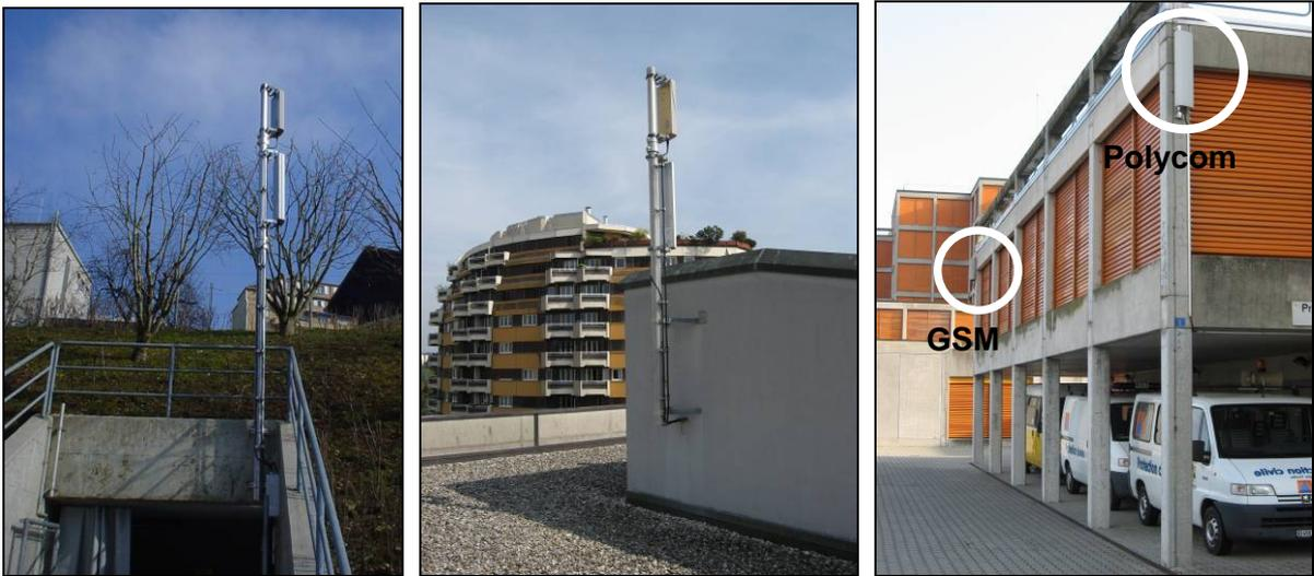
Abbildung 4.1 Beispiele Platzierung Richtantennen Polycom + GSM
