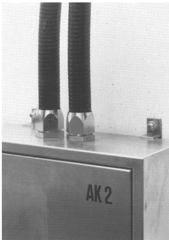
Figur 24 EMP-Rohrverschraubung angeschlossen
