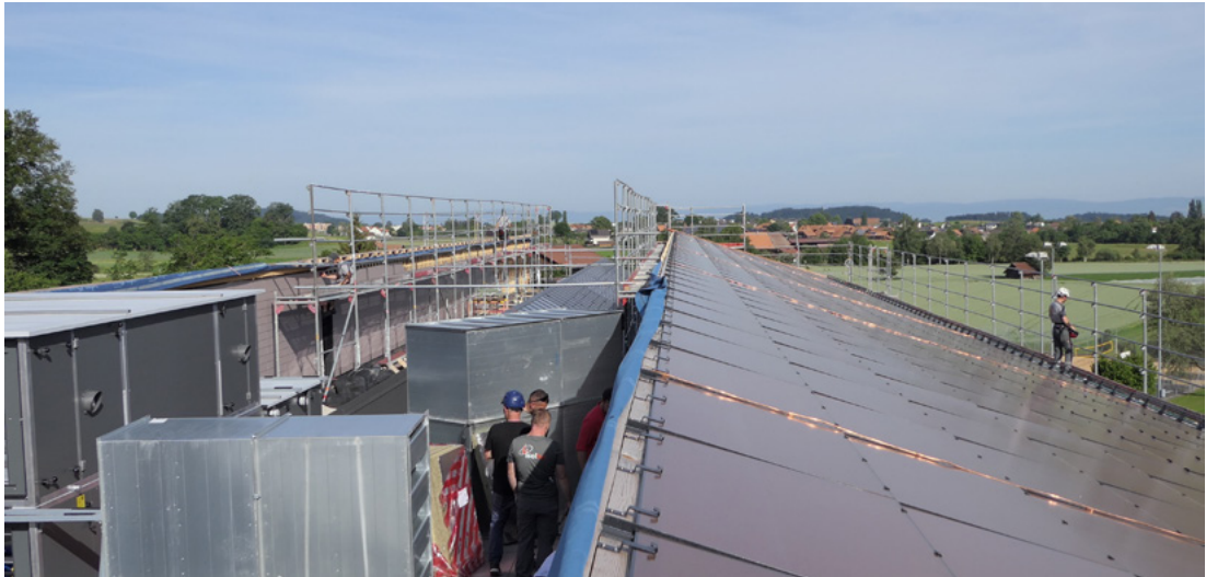
▲ Montage der Photovoltaik-Anlage. © BABS
