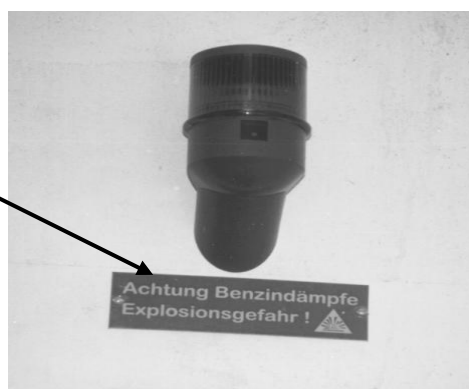
Dettaglio lampeggiante con targhetta
