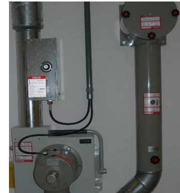
Korrektur Anschluss von VA-Gerät und Heizregister
