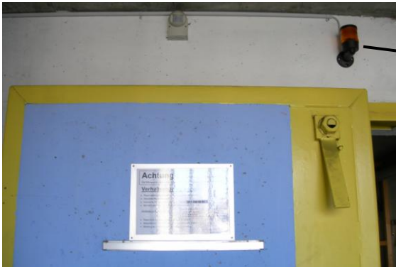
Ansicht vor dem Geräteraum: -Warntafel auf der Panzertüre - Drehlicht gut sichtbar
